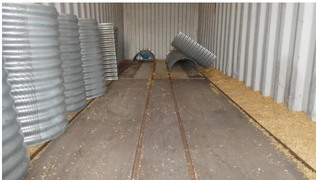
Billede 11. Rundbuer placeres mellem styreskinner i bunden. Billede 12. Interimsistisk hovedkanal mellem containerne. Fotos: Henning Sjørsløv Lyngvig, SEGES
