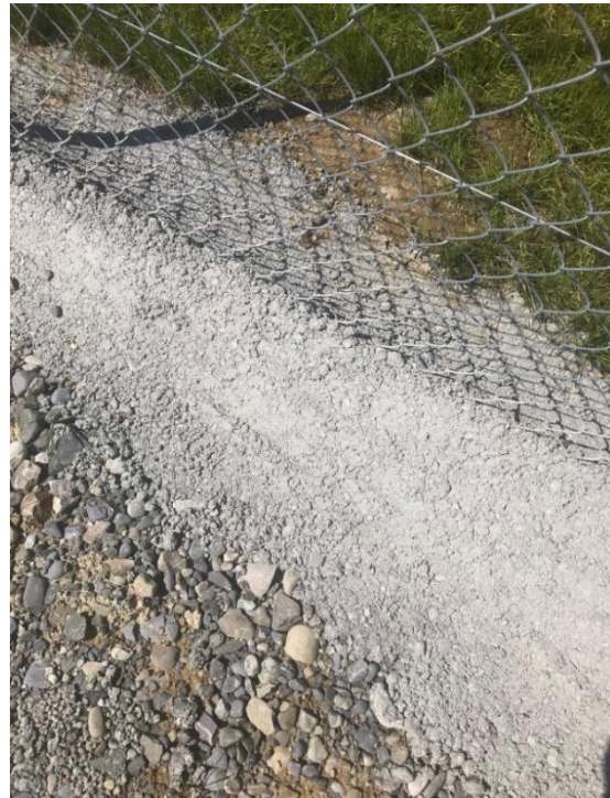
Billede 4. Tråden er nederst støbt ind i beton
