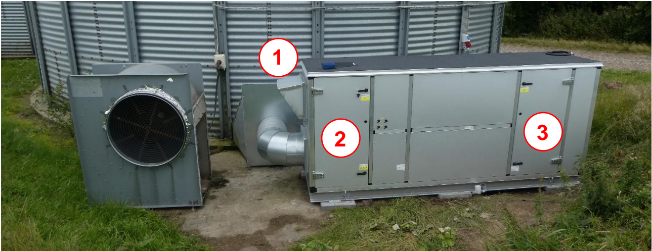
Billede 2. Ved monteringen erstattes stålsiloens 15 kW blæser og 80 kW oliebrænder med JAtrock enheden.
