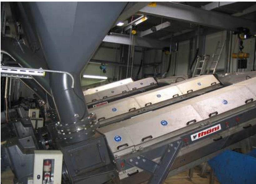
Figur 16: Skuepressere til afvanding af den afgassede biomasse.
