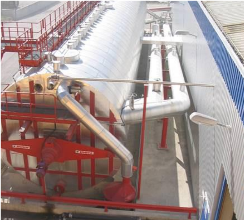
Figur 15: Kompogasreaktor i stål. På siden ses lange tilførselsrør med varmevekslere.
