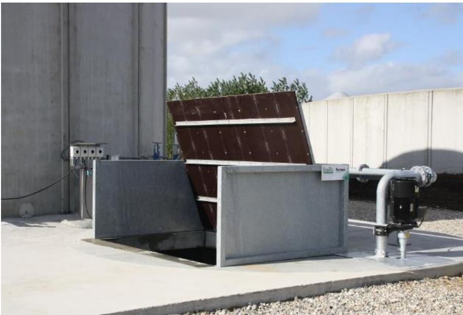
Figur 7: Indtag til faste biomasser foran mixtank
