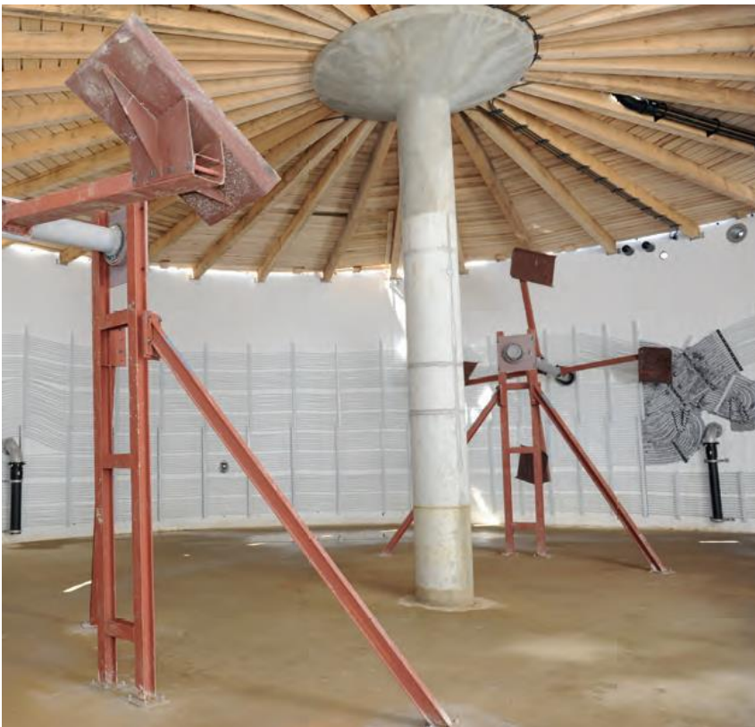
Figur 3: Afgasningstank indefra med paddelgigant-omrørere, bjælkelag og varmeslanger
