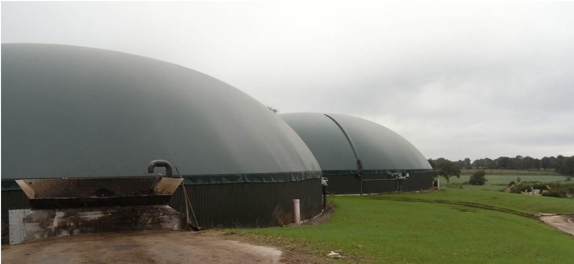
Figur 10: Sauter-anlæg. Forreste tank er primærreaktor med indfødningstragt. Spuledyser på siden af reaktorer.
