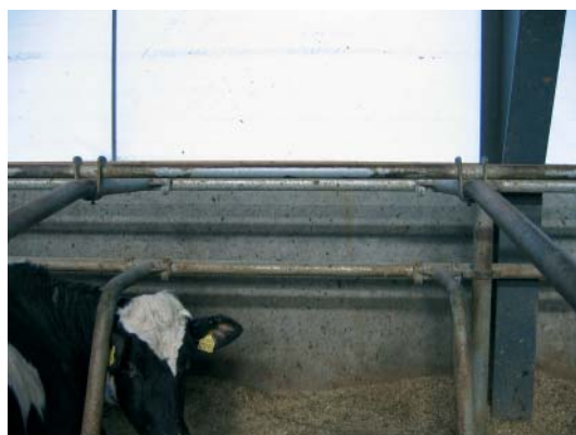
Figur 4.8. Slid på undersiden af nakkebommen.
