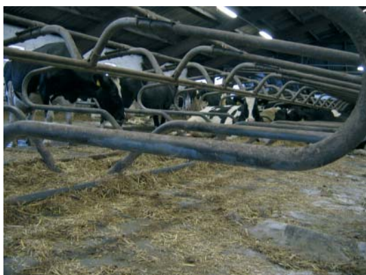
Figur 4.7. Slid på inventar på selve bøjle.
