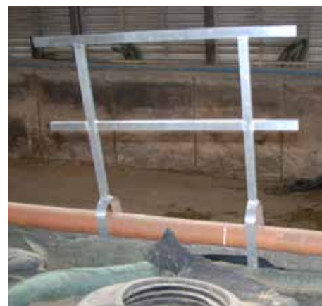
Flytbart rækværk og gode adgangsveje er effektive sikkerhedsforanstaltninger. Foto: SEGES.
