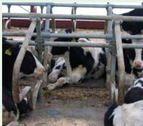
Figur 3.29. Med pilzbøjle undgås generende stolper midt i sengebåsen. Fravær af lavtsiddende frontrør gør det let for kvien at strække benet frem. Hvis det højtiddende frontrør var placeret lidt højere, vil det være endnu bedre.
