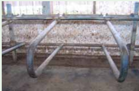
Figur 3.19. (Venstre) Bøjleens udformning gør, at frontrøret sidder højt (40 cm over lejet).
