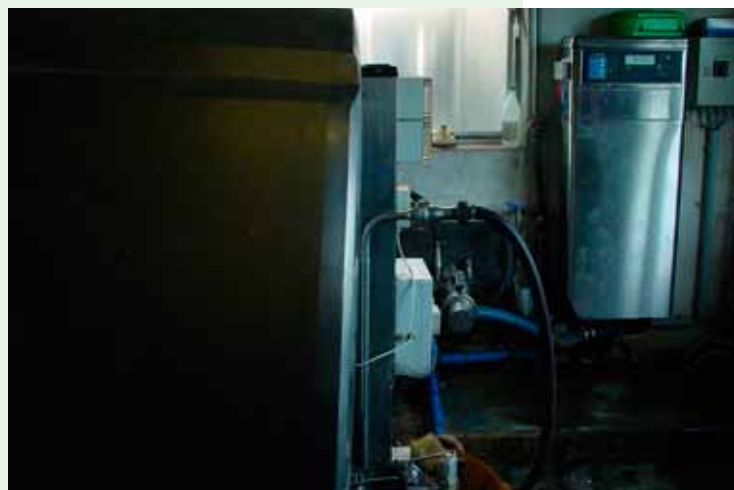
Figur 7. Det gamle mælkerum er nu lavet om til en buffertank. Udenfor står den nye silotank.
