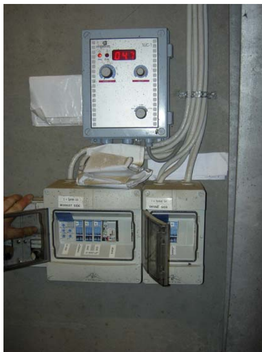
Figur 6.6. Hver gardinside betjenes uafhængigt af hinanden, og har separate følere. Betjeningen og indstillingen er overskuelig.
