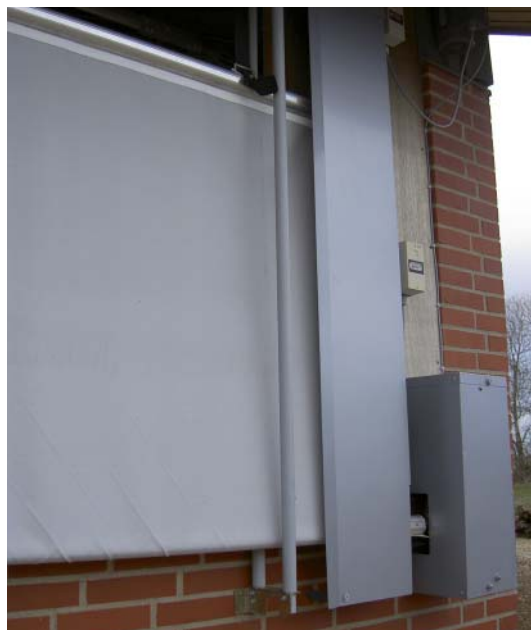
Figur 6.32. Trækmotoren, som holder gardinet på plads på nederste rulle, er godt gemt bag boksen i højre hjørne af billeder. Hele afskærmningen er generelt solid og effektiv.
