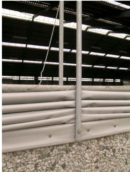
Figur 6.52. Wirerne kræver vedligehold. Er nogle løse, fordeles trækket ujævnt, og enkelte wirer belastes for hårdt og springer som her.
