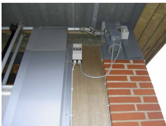
Figur 6.31. Til højre ses trækmotoren, som trækker den tværgående aksel. Solidt dimensioneret, men afskærmningen er kun tilstrækkelig, hvis tagudhænget er bredt.
