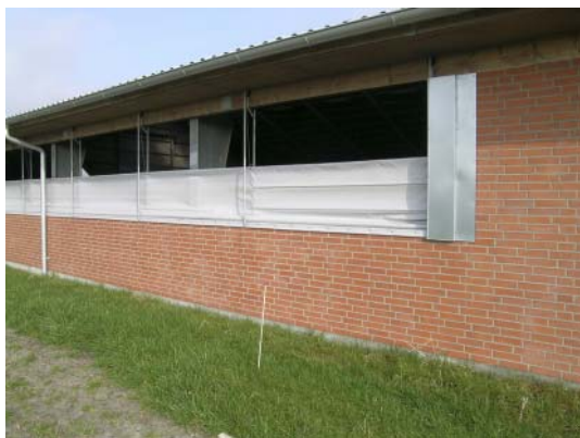
Figur 6.45. Gardinet foldes ovenfra og ned via stålwirer. Det kører mellem styrerør i galvaniseret stål uden beskyttelse.
