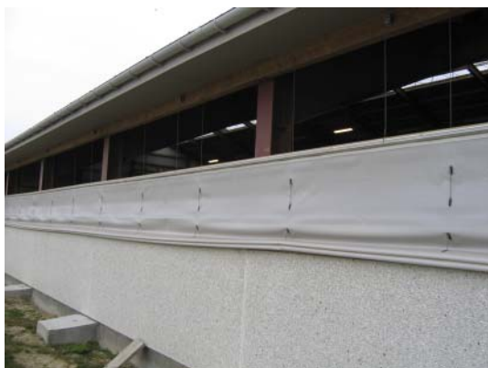
Figur 6.53. Gardinet foldes ovenfra og ned. Det holdes på plads af lodrette wirer.
