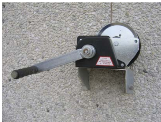
Figur 6.54. Gardinet betjenes via håndsving. Der kan monteres motoriseret betjening og styring med vejstation
