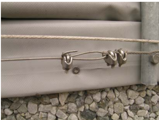
Figur 6.49. Træklinerne var både af stålwirer, stål-tråd og snor. En løsning udelukkende med stålwirer ville være en fordel med hensyn til finish og holdbarhed.
