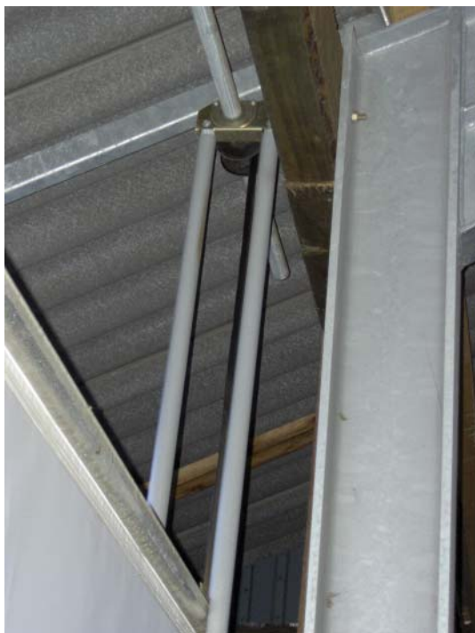
Figur 6.33. Gardinstyret er beklædt med kunststof. Dette nedsætter støjgener og slitage på gardinet.
