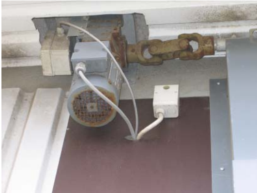
Figur 6.63. Efter blot et år er der kraftigt rustangreb på motor og kardanled. Beskyttelsen er meget mangelfuld.
