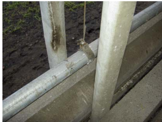
Figur 6.4. Gardinet hejses og sænkes med wirer, som er fastgjort på gardinets topbom. Wirehjul styrer wirene. Opstramning af wirer er relativ simpel ved at løsne to bolte, hvor wiren er fastgjort på bommen.
