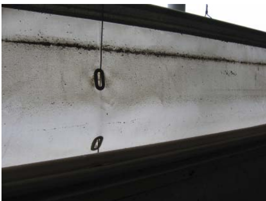
Figur 6.57. Der er tendens til, at skidtet lægger sig i gardinets folder, som det ses her. Dugen er stærk og består af polyesteret PVC.
