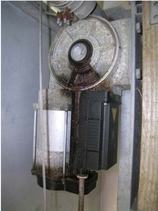
Figur 6.29. Det er vigtigt at vedligeholde og kontrollere gardinet jævnligt. Her ses en utæt pakning i gearet. Olien skader motoren, og udbedres skaderne ikke hurtigt, er gearet også ødelagt.
