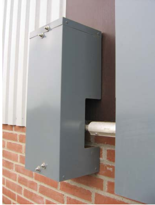
Figur 6.60. Trækmotoren, som holder gardinet på plads på nederste rulle er godt beskyttet af en metalboks.
