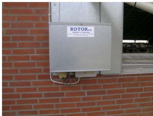
Figur 6.46. Endeafskærmningen er effektivt udført af stålplader. Motoren sidder ligesledes godt beskyttet i en stålkasse.
