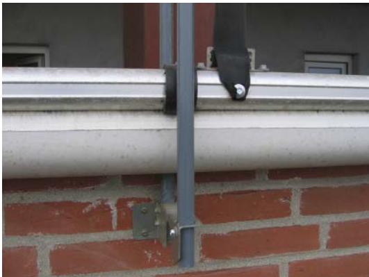
Figur 6.61. Styrerørene er af stål og lakeret. Bommen er monteret med gummi, hvor der er kontakt med styrerørene. Dette mindsker støjgener og slitage.
