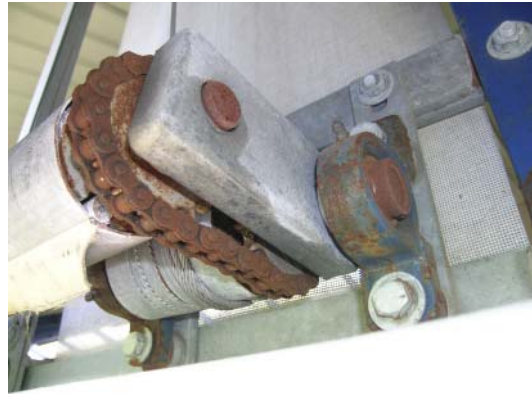
Figur 6.26. Oprulning af gardinet sker for neden. Nederste bom trækkes via kæde og wirer af samme motor som topbommen. Princippet fungerer fint, men bemærk den manglende rustbeskyttelse på mange af komponenterne.
