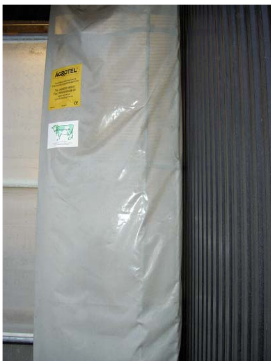
Figur 6.7. Afskærmningen af enden af gardinet og motor er udført i samme pvc-dug som gardinet. En løsning med faste plader er mere stabil og holder læn- gere.
