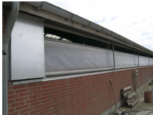
Figur 6.24. Gardinet oprulles på en bom i bunden. Gardindugen er polyestervævet pvc. Gardinstyret består af to lodrette stålrør. Rørene er solidt fastgjort i staldmuren og beskyttet med skum på indersiden for at undgå støjgener.
