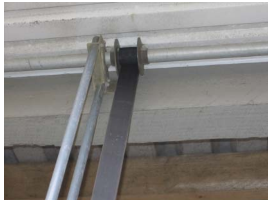
Figur 6.62. Gardinet hejses og sænkes via nylonremme, som er fastgjort på en horisontal trækaksel.
