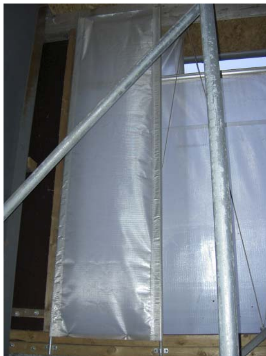
Figur 6.22. Afskærmningen i siderne er udført i gardindug. En afskærmning af faste plader er mere stabil og holdbar.
