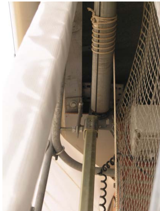
Figur 6.12. Gardinet hæves ved hjælp af nylon-snore, som oprulles på den øverste rulle. Snorene er fastgjort på gardinbommen med beslag. Opstramning er simpel, men tidskrævende.
