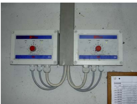
Figur 6.37. Motoriseret betjening med manuel styring. Hver gardinside betjenes uafhængigt af hinanden ved hjælp af drejknapper. Princippet er simpelt at betjene.
