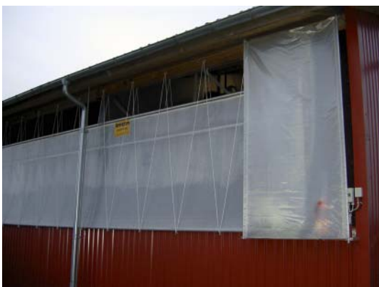
Figur 6.17. Gardinet rulles ovenfra og ned.
