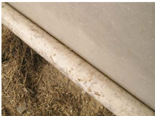
Figur 6.15. Der er mange fordele ved gardiner i hele staldens højde. Ulempen er, at der lettere kommer skidt med i oprulningen, som slider på gardinet og giver et skævt træk. Vand og frost er ligeledes uheldigt i oprulningen.
