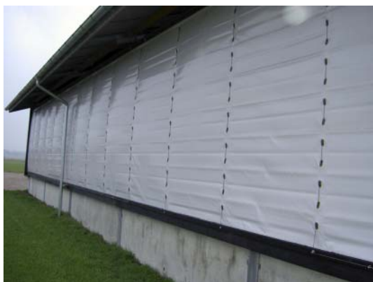
Figur 6.39. Gardinet foldes ovenfra og ned. Gardinet kører på fastgjorte wirer via et wiresystem, som hæves og sænkes ved hjælp af håndsving
