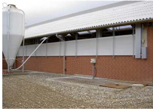
Figur 6.36. Gylleomrøringen bør ikke foregå lige under gardinmekanikken som her. Det kan medføre kraftig korrosion på mekanikken på grund af ammoniak-dampene.
