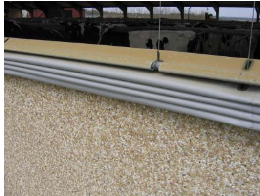
Figur 6.44. Dugen er viklet omkring bommen. Løsningen er ikke så holdbar, som hvis dugen var monteret i en skinne på bommens underside. Bemærk hullerne i dugen ved styrewiren på grund af slitage.
