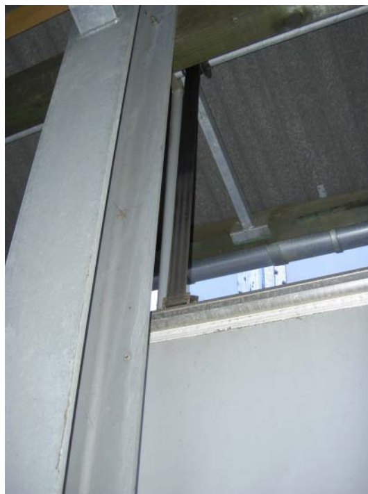
Figur 6.34. Gardinet hæves og sænkes via nylonremme, som er fastgjort på trækaksel og gardinbom.
