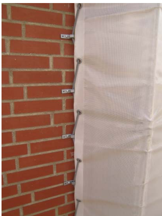
Figur 6.13. Endeafskærmningen er let at fjerne, så man kan komme til mekanikken.
