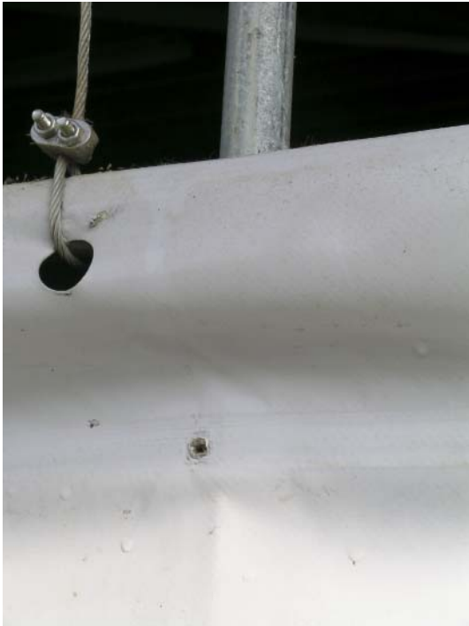
Figur 6.47. Wirerne er fastgjort til gardinbommen med et spændebånd. Opstramning er simpel ved at løsne to møtrikker. Bemærk hullet i gardinet, som skyldes slitage ved styrerøret.
