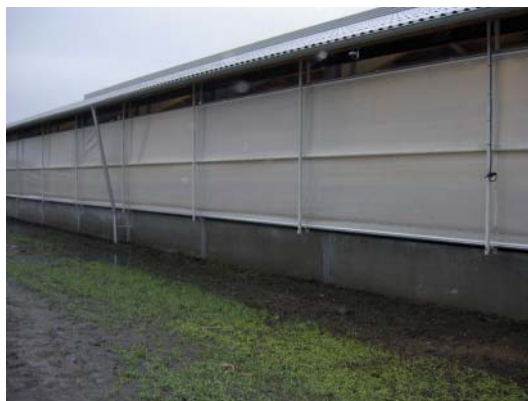
Figur 6.2. Gardinet oprulles på midten mellem top og bund. Selve nedrulningen sker fra top mod bund, men retningen kan vendes. Bommen i midten giver en god afstivning og en solid konstruktion.
