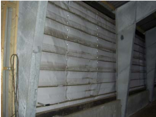
Figur 6.43. Der er tendens til, at skidtet lægger sig i gardinets folder. Dugen er stærk og består af polyestervævet pvc.
