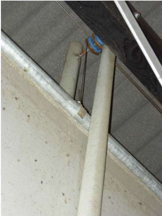
Figur 6.3. Styrerørene er beklædt med nylon. Dette nedsætter støjgener og slitage på gardinet og fremmer levetiden. Wireruller er efter ½ års brug angrebet af rust.
