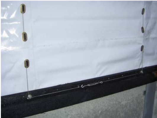
Figur 6.41. Gardinet holdes på plads af stålwire, som er fastgjort i top og bund. Opstramningen er simpel ved hjælp af en justerskrue.
