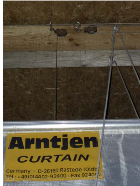
Figur 6.20. Oprulning af gardinet sker ved hjælp af stålwire, som hæver bommen. Opstramning af wire er relativ simpel ved at løsne to bolte, hvor wiren er fastgjort på bommen. Opstramningen er tidskrævende.
