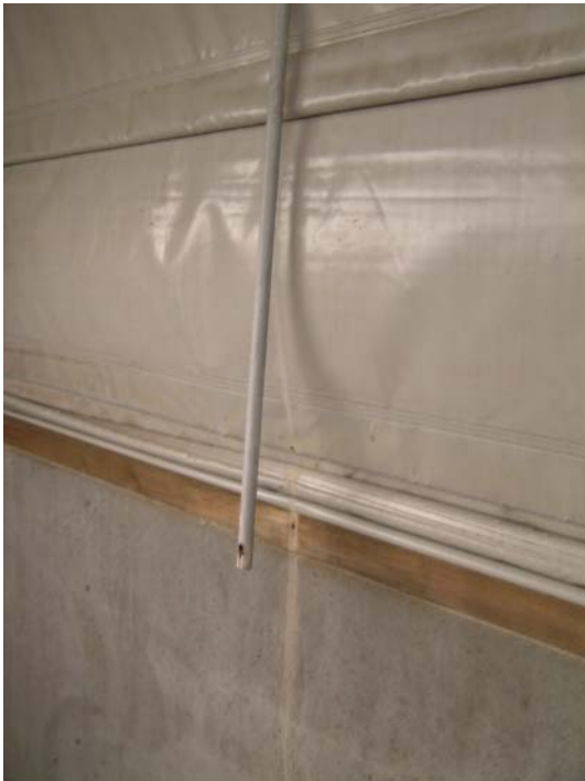
Figur 6.51. Styrerrørene var ikke tilstrækkeligt fastgjorte. Her er et, som har løsgjort sig og rykket bolten ud af væggen. En polstring af rørene vil nedsætte slitage på gardinet.
