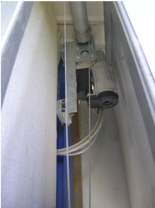
Figur 6.23. Motoren, som opruller gardinet, trækker både den øverste og nederste bom. Kraftoverførslen mellem motor og nederste bom sker ved hjælp af wirer.
