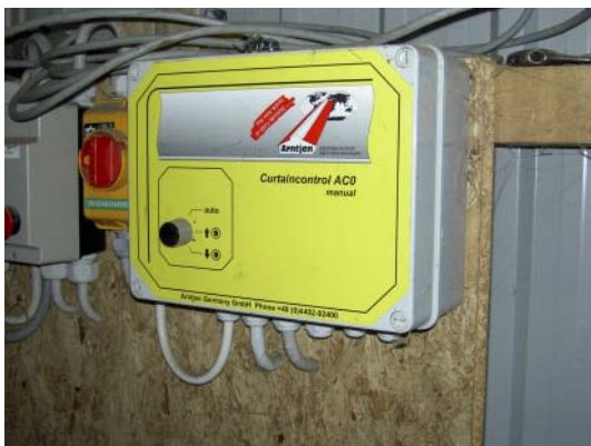
Figur 6.21. Betjeningen er simpel og foregår via en drejeknap. En vejstation kan kobles på, så styringen foregår automatisk.
