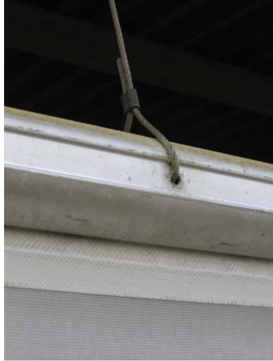
Figur 6.56. Op- og nedrulning sker med stålwirerspil. Wiren er fastgjort gennem bommen med permanente wirelåse, som ikke kan afmonteres eller løsnes ved opstramning af wirer.
