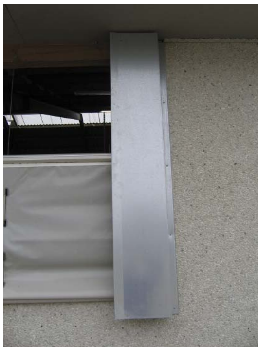
Figur 6.58. Endeafskærmningen er solid og vel-fungerende. Der kan opstå støj, når gardinbommen slår mod afskærmningen.
