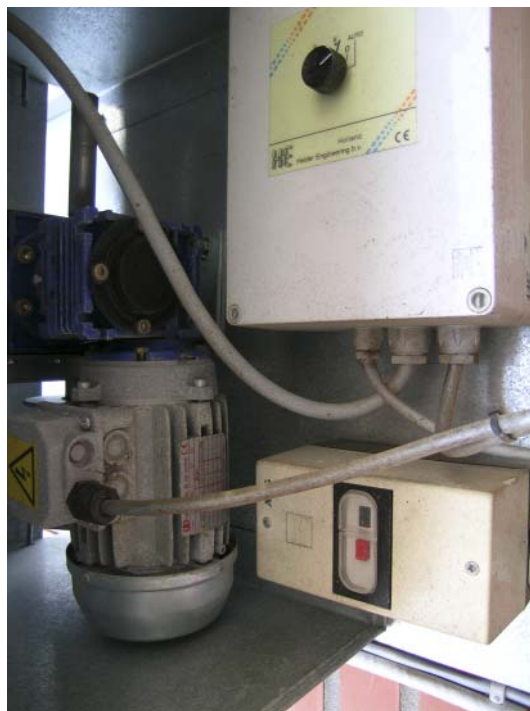
Figur 6.50. Motoren var godt afskærmet og velfungerende. Kontakten til toppen af billedet var mellem manuel styring og vejrstation.
