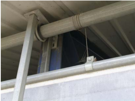
Figur S6.25. Styrerørene er beklædt med skum på indersiden, som mindsker støjgener og slitage. Wirer hæver gardinet via en vandret bom. Dermed er der få wirer og ingen hjørnehjul at vedligeholde.
