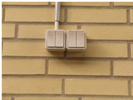
Figur 6.16. De manuelle kontakter er lette at betjene, men medfører, at gardinet ikke altid bliver justeret i tide. Overvej en vejrstation til styring. Så undgås våde båse, og der er optimalt staldklima.
