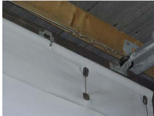
Figur 6.42. Op- og nedrulning sker via stålwire og hjørnehjul. Wiren er viklet rundt om bommen og fastgjort med permanente wirelåse, som ikke kan afmonteres.
