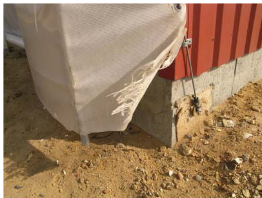
Figur 6.14. Holdbarheden på endeafskærmningen er ikke god. Efter seks måneder er de første defekter indtruffet. En afskærmning i faste plader er mere solid med længere levetid.
