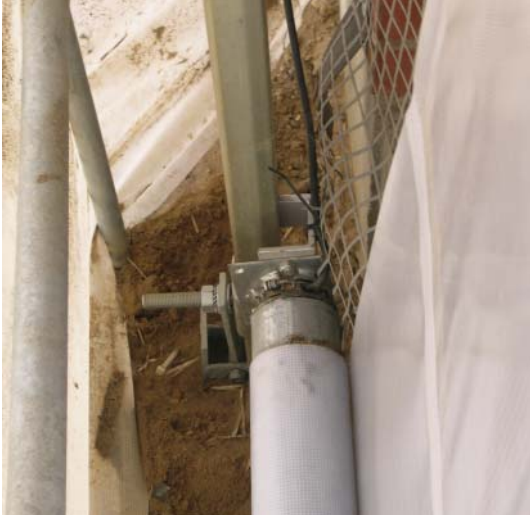
Figur 6.9. Midt i billedet ses bommen, hvor den lille motor er placeret. Motor og bom kører op og ned på en skinne, hvis gardinet kører nede fra og op.
