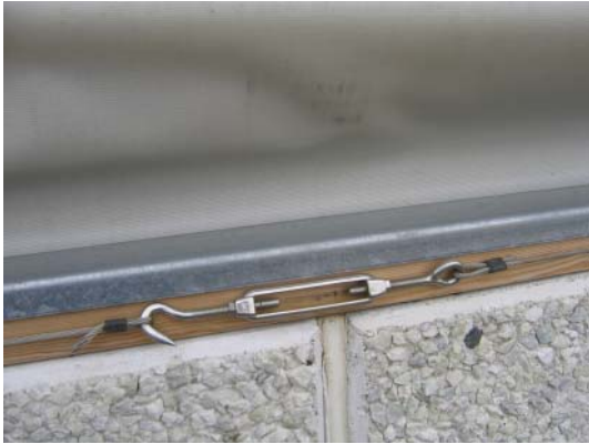
Figur 6.55. Gardinet holdes på plads af stålwirer, som er fastgjort i top og bund af staldmuren. Opstramningen er simpel ved hjælp af en justerskrue.
