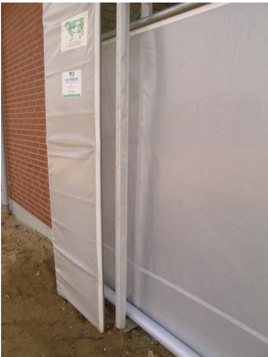
Figur 6.11. En isolering af styrerørene nedsætter støjgener og slitage på gardinet. Endeafskærmningen er ligeledes lavet af gardindug.
