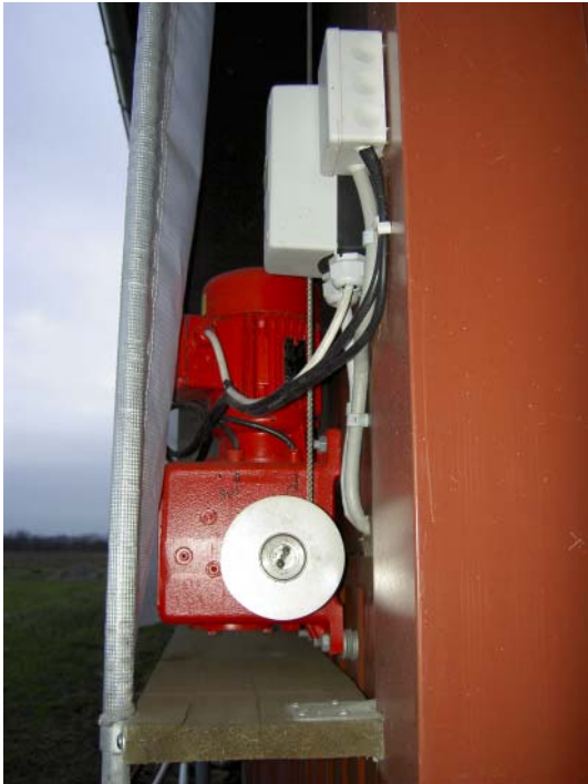
Figur 6.19. Elmotoren, som op- og nedruller gardinet. Motoren sidder beskyttet bag en afskærmning af gardindug.
