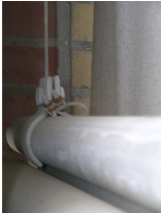
Figur 6.28. Gardinet hæves og sænkes med wirer. Opstramning sker ved at løsne to møtrikker og stramme wiren. Simpelt, men tidskrævende, specielt hvis møtrikkerne, som her, ikke er rustbeskyttet.
