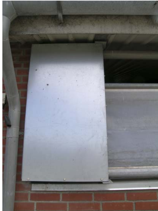
Figur 6.30. Endeafskærmningen er hjemmelavet af stålplade. Simpel og solid. Levetiden er meget bedre end afskærmning af gardindug.
