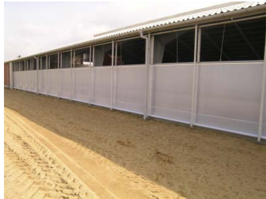
Figur 6.10. Gardinet kan både åbnes ovenfra og nede fra. Oprulningen sker på den nederste bom. Styrestængerne er galvaniseret og betrukket med samme pvc som gardinet.
