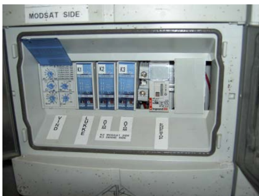
Figur 6.5. Automatisk styring med vejrstation. Her indstilles grænseværdier for temperatur og vindhastighed. Præcisionen er ikke helt på højde med digitalt display, men fungerer tilfredsstillende.
