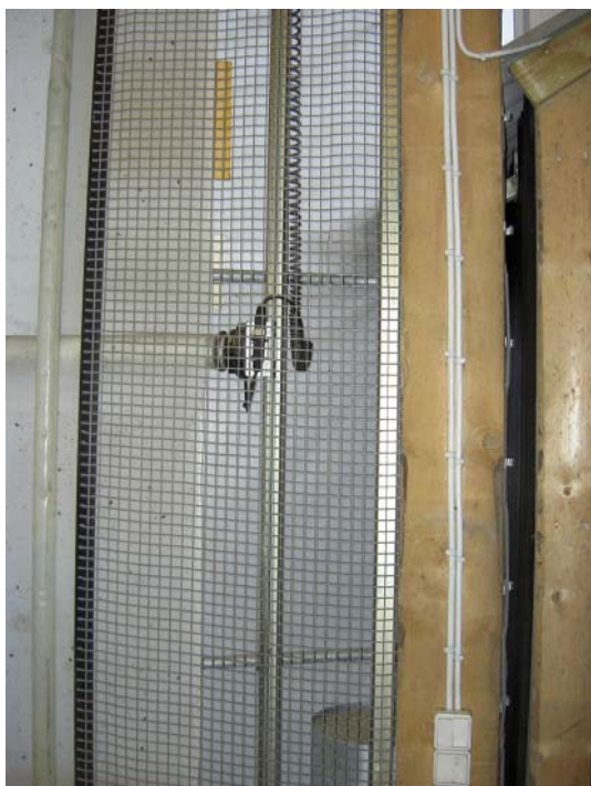
Figur 6.1. Midt i billedet ses den lille motor, som opruller gardinet. Motor og midterbom kører op og ned på en skinne. Nederst i billedet ses kontravægten.
