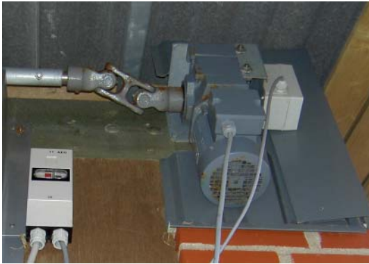
Figur 6.35. Bemærk rust på motor og kardanled. Gardinet er kun to til tre måneder gammelt. Rusten skyldes enten dårlig overfladebehandling eller ammoniak-dampe.
