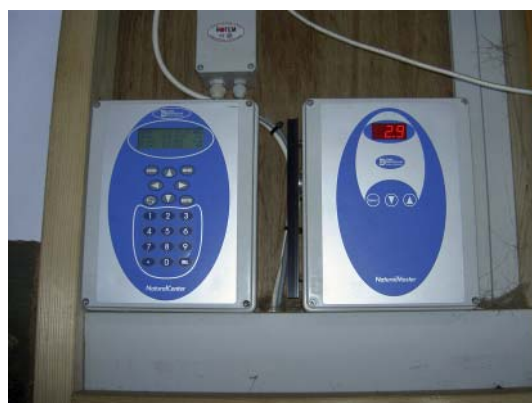
Figur 6.38. Motoriseret betjening og styring med vejrstation. Styringen foregår via et digitalt display i et menu-system. Her indtastes grænseværdier for temperatur og vindhastighed. Menuen er logisk opbygget og let at betjene efter en kort introduktion.
