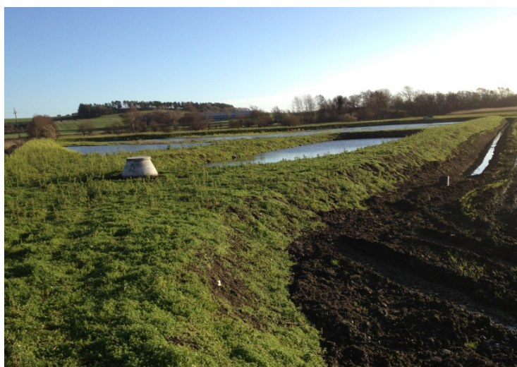
Her et eksempel fra et minivådområde i Nordjylland, etableret på et fladt areal. Bassinerne er åbne uden træflis men opbygningen af volde vil i princippet være det samme ved Hofmansgave. Foto: Anne Birgitte Thing
