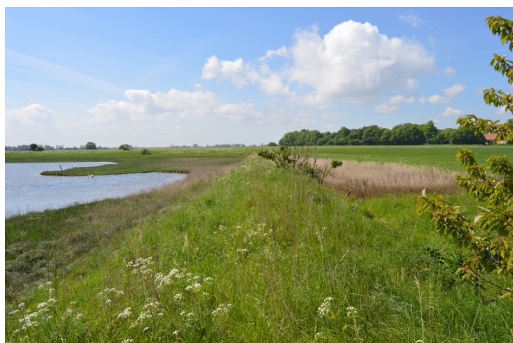
Området set fra diget. Bassinerne vil blive etableret umiddelbart bag ved diget til højre i billedet. Foto: Frank Bondgaard
