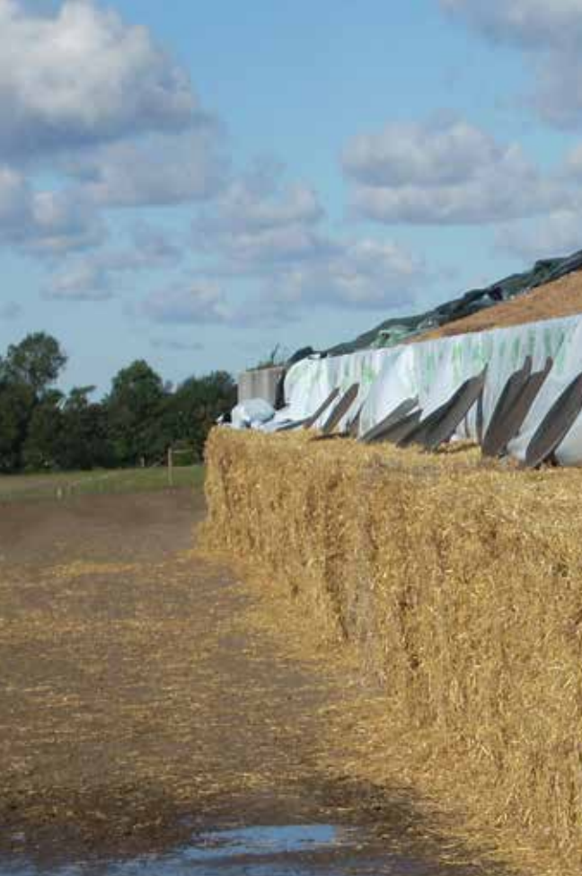
Halmballer bruges som beskyttelse mod fald fra kanten af plansiloen.
