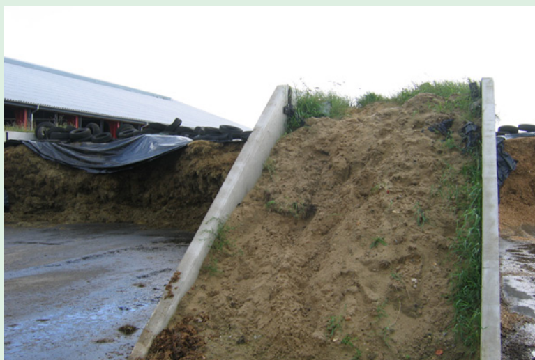
Figur 16. Hollændersilo, hvor der er en jordvold mellem elementerne. Dette giver ekstra plads til dæk og plast i forbindelse med til- og afdækning af ensilagen. Desuden kan mængden af beton reduceres, da volden stabiliserer siderne.
