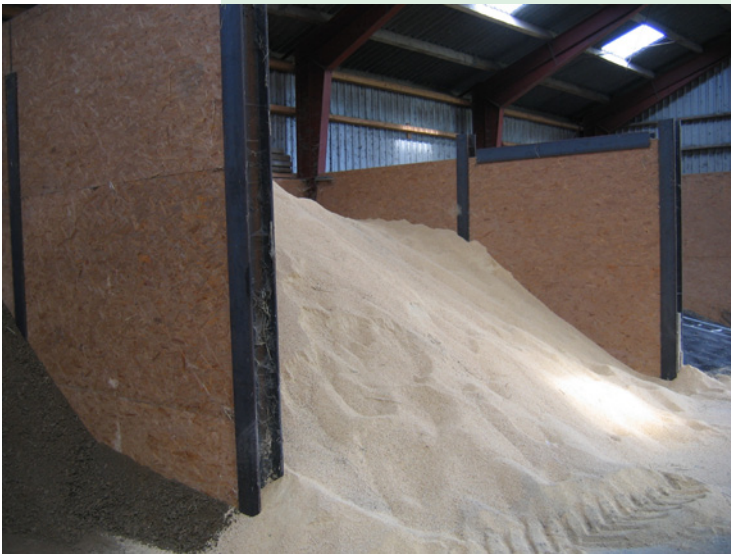
Fig. 9. Silo i foderlade.
