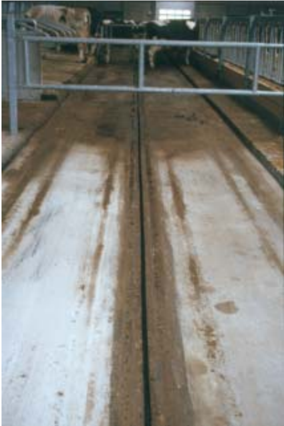
Veldrænet gangareal med et PolyFlex-rør i midten.
