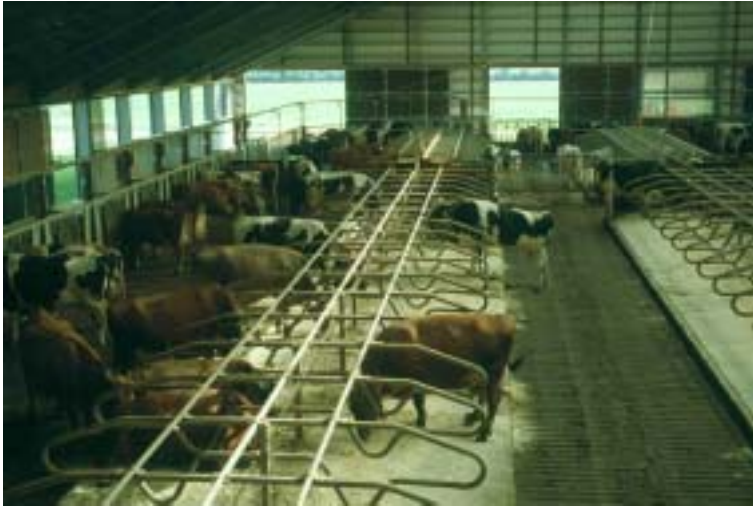
Sengebåse med savsmuld. Skraber i 40 cm dyb kanal.
