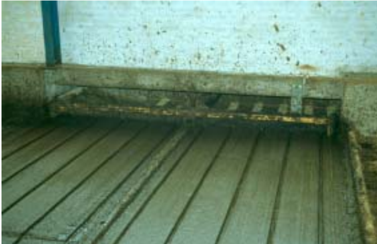
Gulvet skræbes helt rent. Profileret gulv fra Perstrup Beton Industri A/S med skraber fra Mullerup Staldteknik A/S.
