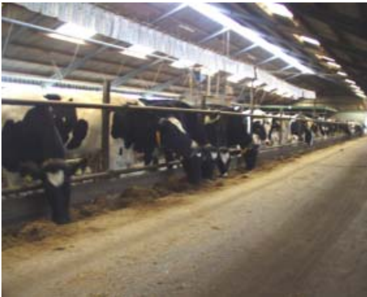
Der er foderbord i hele staldens længde. Naturlig ventilation og ovenlys.
