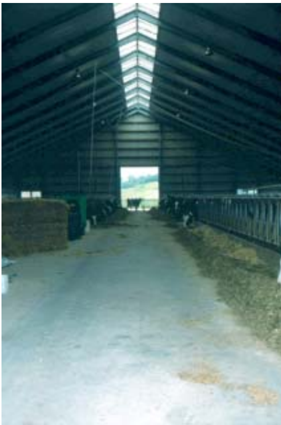
Der er foderbord i hele staldens længde. Naturlig ventilation.
