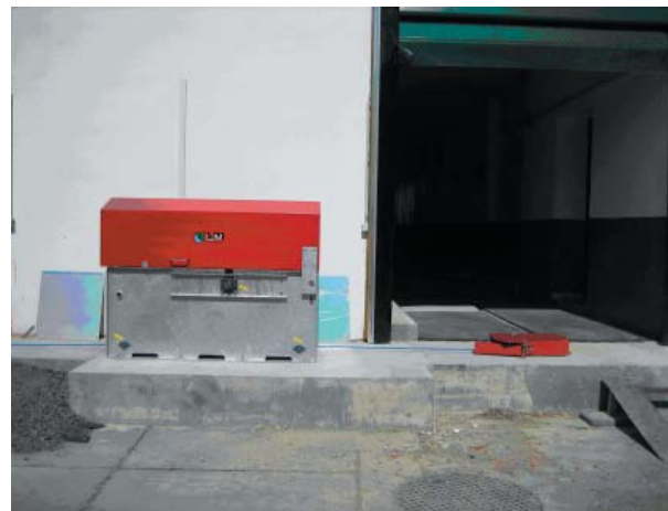
Figur 5.28 og 5.29. Wireanlæg fra LJM Agro. Et wireanlæg er simpelt og billigt, men kræver mere vedligehold end andre skrabeprincipper.
