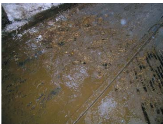
Figur 6.1. Risten til tværkanalen er pakket til pga. strøelse og møget afleveres ikke som tiltænkt, men skubbes videre hen over afleveringsstedet.
