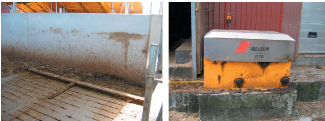
Figur 5.30 og 5.31. Skioold Mullerup tilbyder flere typer skraber. Her ses en D 70 wiretrukket spalteskraber.
