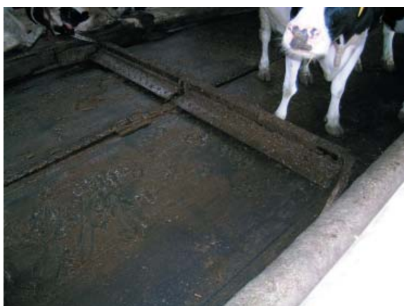
Figur 6.4. Gummigulve er lettere at holde rene, idet der ikke stilles samme så store krav til overfladeretheden. Gulv og skraber former sig efter hinanden og man reducerer urinsøer og gødningsklatter pga. ujævnheder. Desuden opnås bedre skridsikkerhed for kørerne med gummigulvet.
