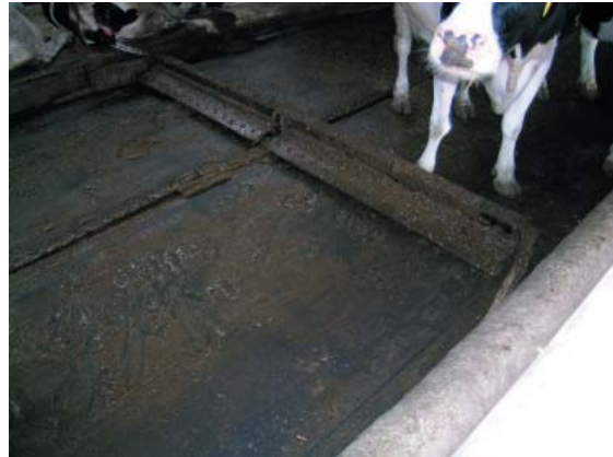
Figur 5.18. Joz fastgulvsskraber med kædetræk. Her på gummigulv.
