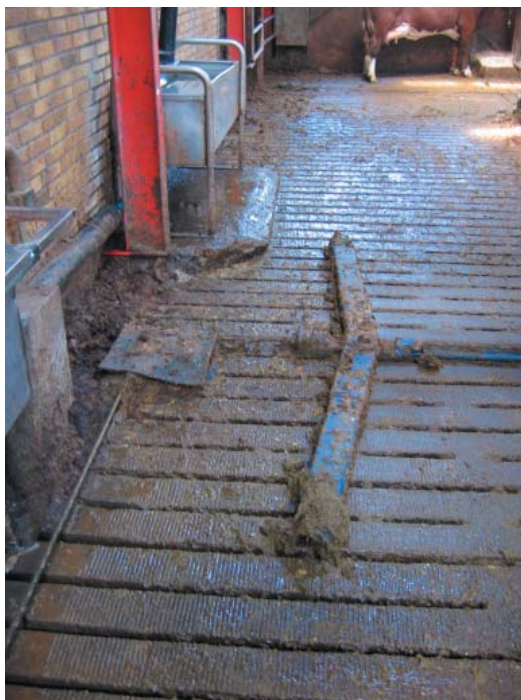
Figur 5.16. Rebtrukket Delaval spalteskraber kræver jævnlig rengøring. Ellers øges friktionen med stigende energiforbrug og slitage til følge.
