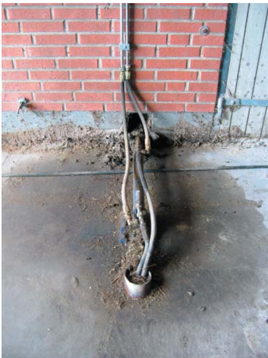
Figur 5.15. Hydraulisk cylinderen trækkes af en hydraulikstation. Cylinderen trækker en skinne som skubber skraberens frem og tilbage.
