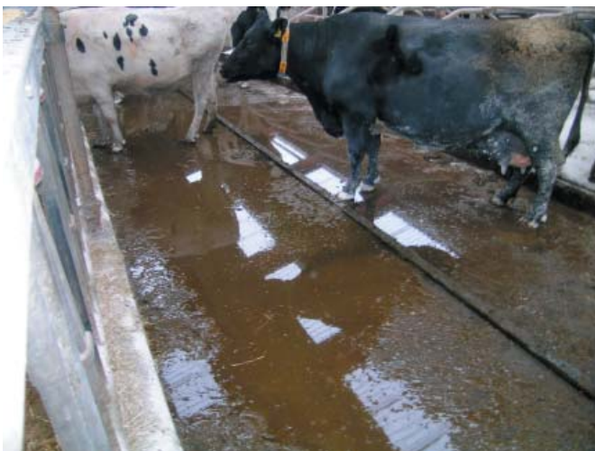
Figur 6.3. Er gulvet af dårlig håndværksmæssig kvalitet med mange ujævnheder kan selv det bedste skrabe anlæg ikke skrabe rent. Dermed opstår der permanente urinsøer med dårlig hygiejne og sundhed til følge.
