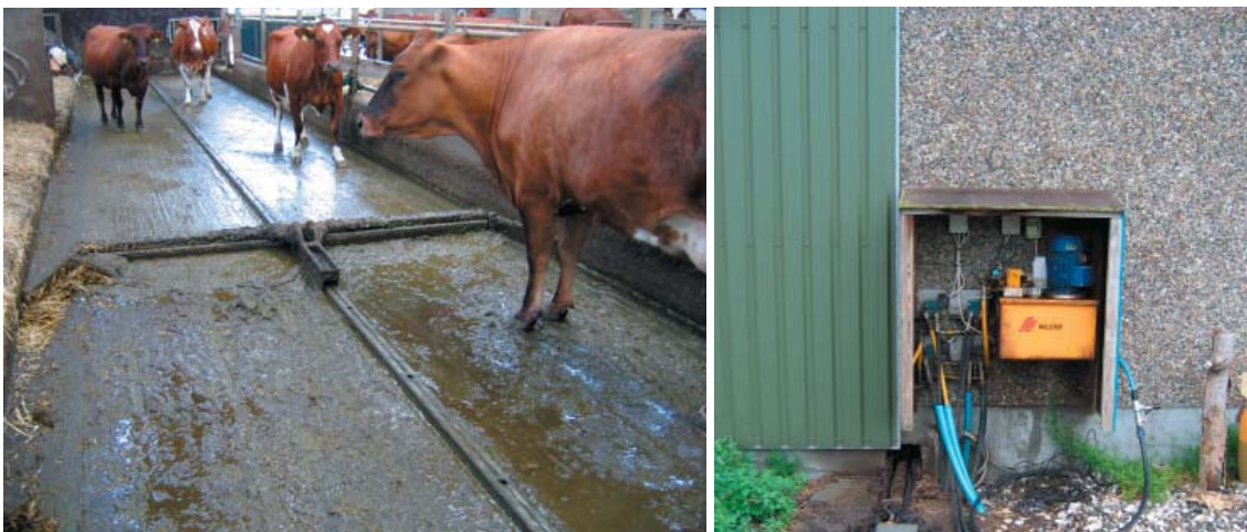
Figur 5.32 og 5.33. Hydraulisk fastgulvsskraber. Anlægget kan tilpasses med undersænket trækskinne samt trækskinne oven på gulv – som vist. Ligeledes til gulvtyper fra Perstrup og gulve med Polyflex render. Anlægget leveres i Silent udgave med væsentligt reduceret støjniveau (fra 65 DB til 55 DB).
