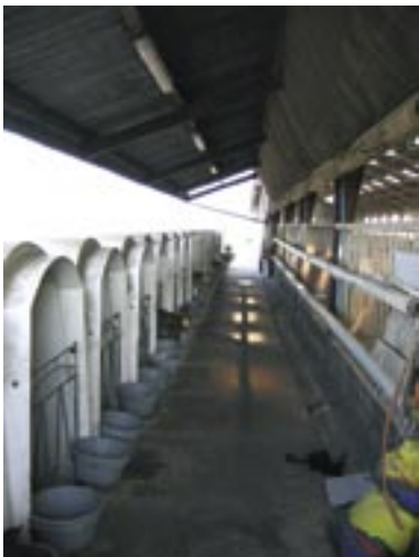
Figur 5.2 - Taget på kostalden er forlænget, og der er monteret lys på udhænget, således at det er muligt at tilse kalvene selv om det er mørkt.
