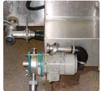
Foto 3. Mælkpumpe til overpumpning af mælk. Pumpen anvendes samtidig som vaskepumpe.
