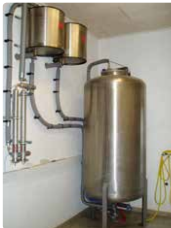
Foto 2. Buffertank i et AMS-system.
