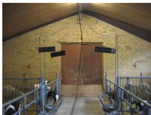
Figur 10. Hovedvandleddningen er fremført under loftet igennem hele stalden. Drikkekopperne er tilsluttet med bløde plastikslanger. De sorte plader er fluetavler. Den murede gavl udgør sektioneringen til næste sektion.
