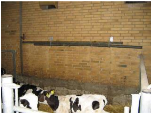
Figur 5. Kroge på væggen til ophæng af ekstra rør til boksadskillelsen.
