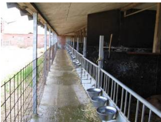
Figur 4. Rionettet danner en drivgang foran boksene. Stalden er delt på tværs af en væg af vandfast krydsfiner. Boksene adskilles af plader af vandfast krydsfiner.
