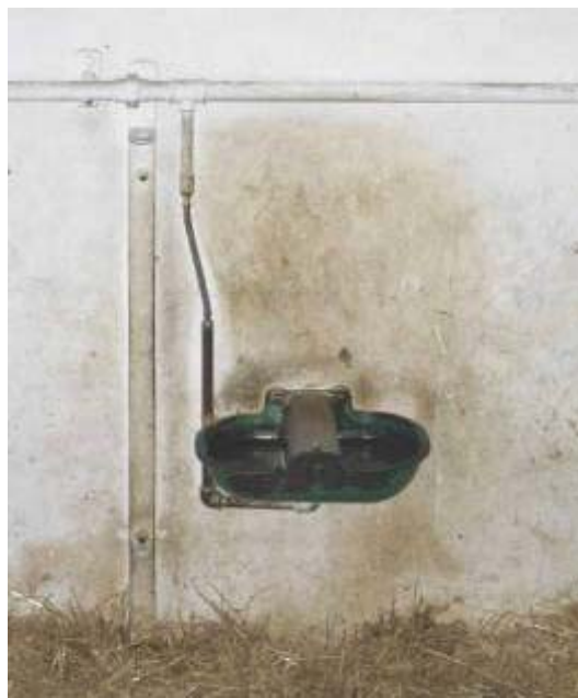
Figur 8. Dobbelt drikkekop med vandspejl.
