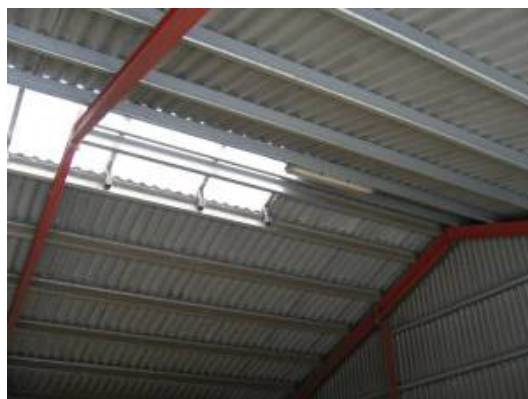
Figur 7. Tag af fibercementplader og åben kip med lysplader.
