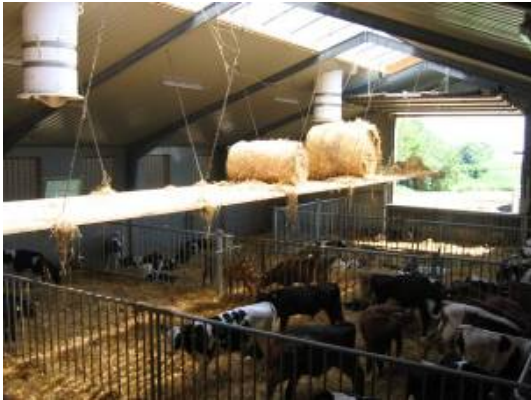
Figur 10. Gangbro til strøning.
