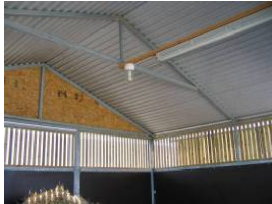
Figur 4. Bræddetempel i den øverste del af væggene, i loftet et lysstofrør samt en staldlampe.
