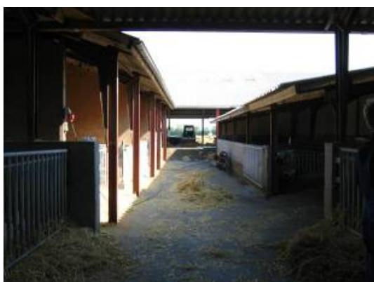
Figur 9. Den uoverdækkede fodergang midt i starterstalden bidrager ligeledes med dagslys og luft.
