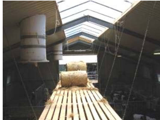
Figur 4. Åben Kip overdækket af lysplader, er to ventilationskorstene i taget.
