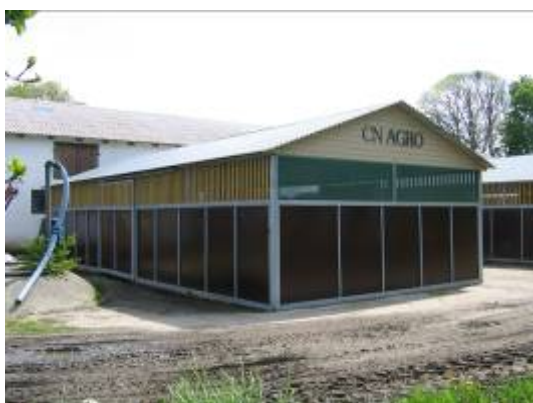
Figur 12. Der er bræddetrempel øverst i facaderne og vindbrydende net øverst i gavlene (ejendom A).
