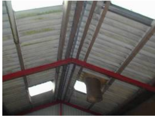
Figur 4. Taget med lysplader og udsugningsventil.
