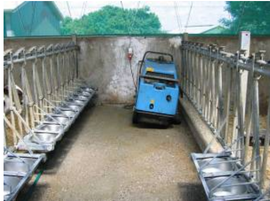
Figur 15. Elstik til højtryksrensere og vandudtag rundt i hele stalden letter arbejdet med at rengøre.
