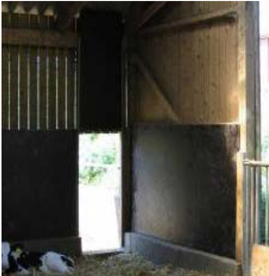
Figur 7. Plader på indersiden til 1,2 meter og åben dør til løbegården.
