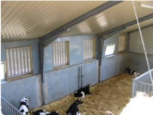
Figur 3. Stålspær, isoleret tag, pudsede vægge, vinduer og rektangler med gælleplader.
