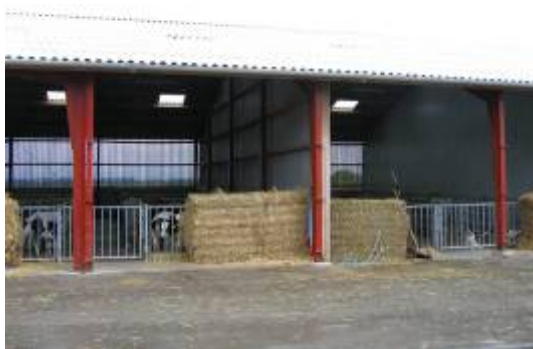
Figur 4. Åben facade mod syd, bræddetrempele mod nord og eternittag.
