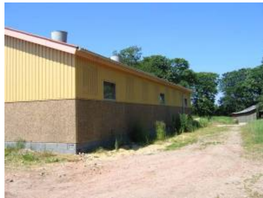
Figur 6. Facade af betonelementer og stålplader med vinduer og gælleplader.
