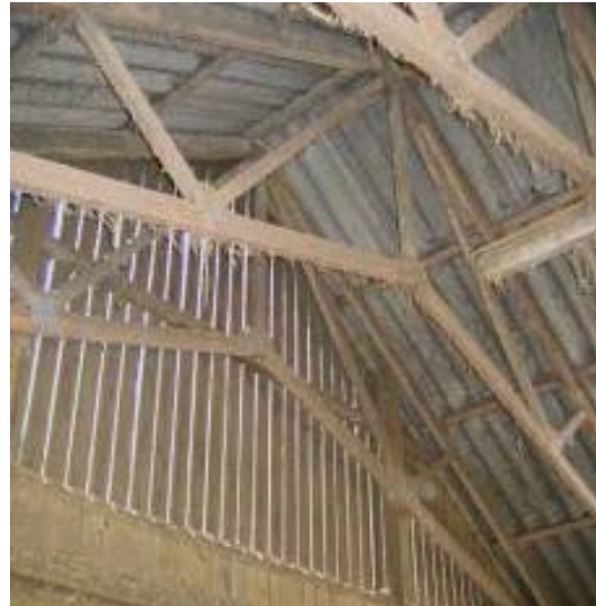
Figur 8. Sakse træspær, bræddetempel i gavltrekanten og fibercementplader på taget.
