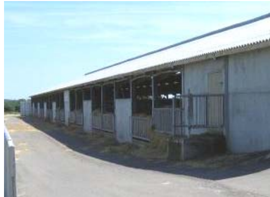
Figur 4. Facade mod nord med høhække som låger.
