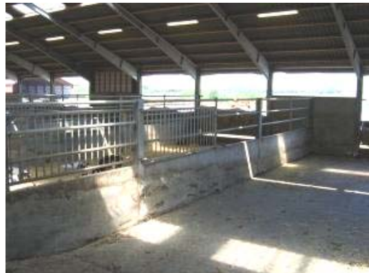
Figur 6. Boksadskillelse, nederst beton mur, øverst vandrette rør.
