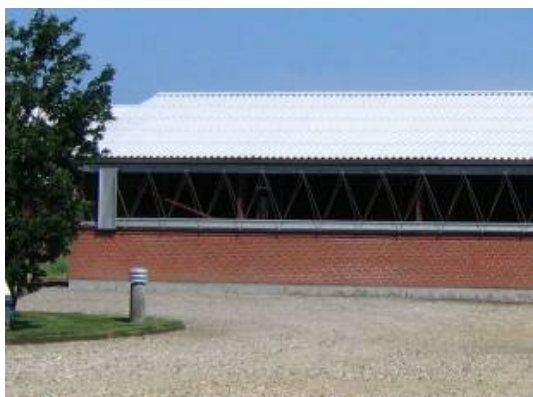
Figur 7. Ydervæggene består af halvmure med gardin over, her kommer dagslys og luft ind.
