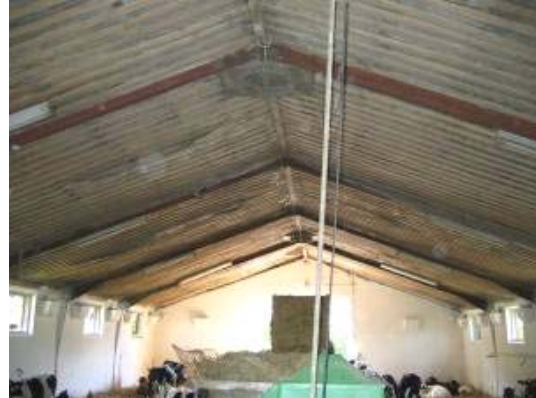
Figur 4. Stålspær, isoleret loft med to ventilationskorstene og to lystofrør pr. fag.
