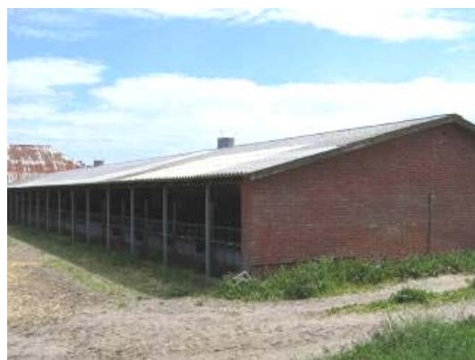
Figur 5. Kalvestalden set fra vest, en ombygget svinestald fra slutningen af 1960'erne, med fuldmuret gavl.
