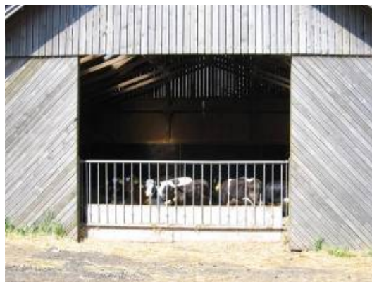
Figur 6. Port i gavlen som giver adgang til strøning og udmugning, samt lys og luft.
