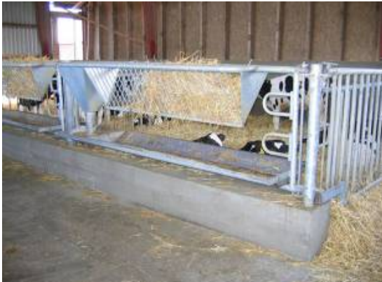
Figur 11. Forværk med kombineret langkrybbe, foderautomat og høhæk.
