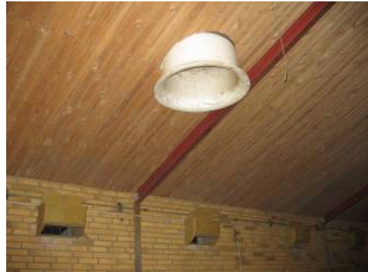
Figur 4. Der er en mekanisk ventilations-skorsten i hver sektion.
