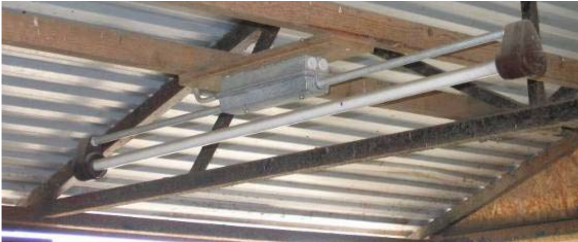
Figur 3. Lysstofrør i hytterne sikre godt lys ved kalvene .
