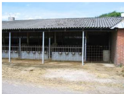
Figur 10. Afstanden mellem de bærende træstolper var afgørende for størrelsen på boksene.
