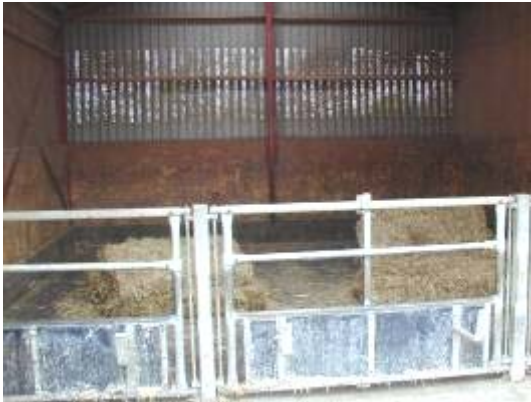
Figur 3. En sektion med gælleplader på bagvæggen.
