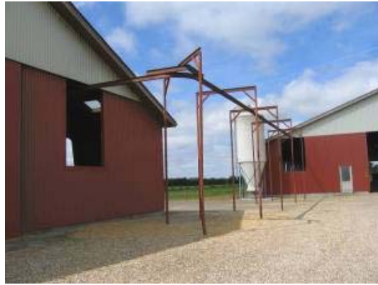
Figur 13. Hængebane strømaskinen deles med slutstalden ved siden af.
