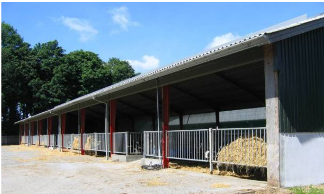
Figur 1. Starterstald A med tre sektioner, åben facade mod syd.
