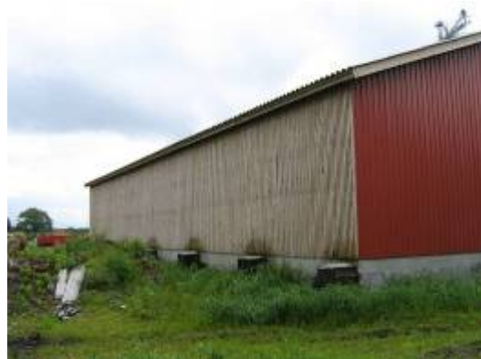
Figur 5. Bræddetrempele i facade mod nord.
