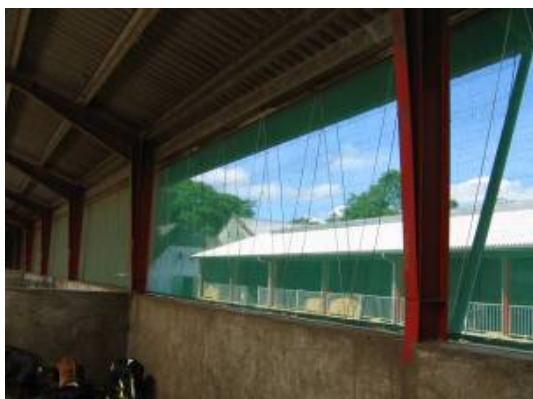
Figur 6. Betonmur og gardiner af vindbrydende net i facaden mod nord.
