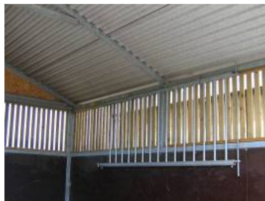
Figur 6. Tremmelåge til boksadskillelse hænger på væggen, når den ikke er i brug.
