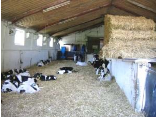
Figur 3. Fuldmurede vægge med vinduer og ventilationsventiler.
