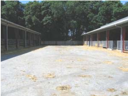
Figur 14. Betongplads mellem starterstald og slutstald, godt kørefast underlag til bl.a. udmugning og strøning.
