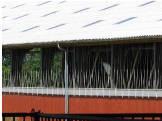
Figur 4. Gardin i facaden, fibercementplader med lysplader i taget.
