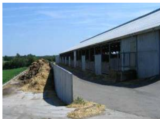
Figur 14. Asfalteret vej langs staldens bagside, en 3 meter høj mur afgrænser vejen fra den lange møddingsplads.
