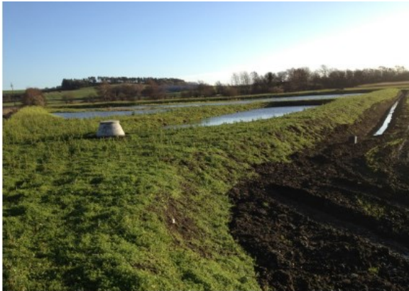
Her et eksempel fra et minivådområde i Nordjylland, etableret på et fladt areal. Bassinerne er åbne uden træflis men opbygningen af volde vil i princippet være det samme ved Hofmangsgave. Foto: Anne Birgitte Thing
