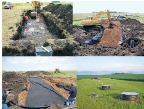
Bioreaktor med træflis i USA kaldes de woodchip bioreactors. Foto: Laura Christianson og Matthew Helmers, 2011
