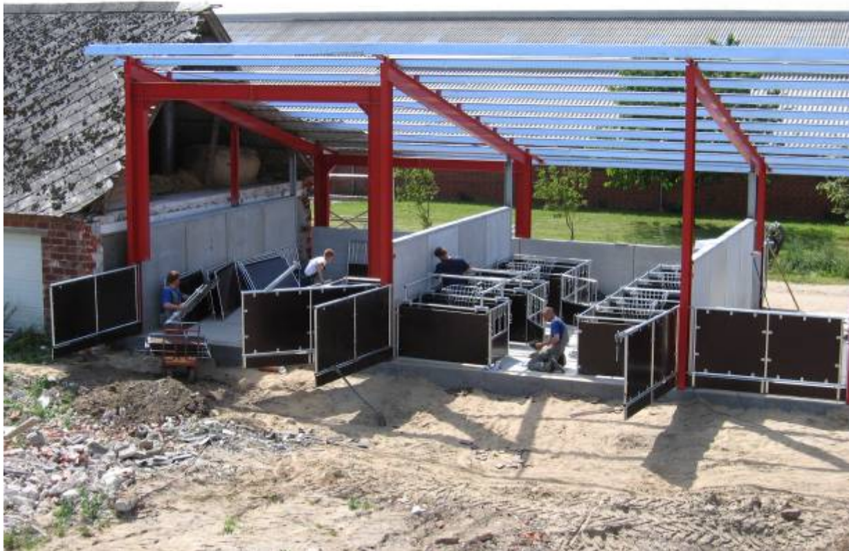
Montage af enkeltbokse, 24 i alt fordelt på to sektioner.
