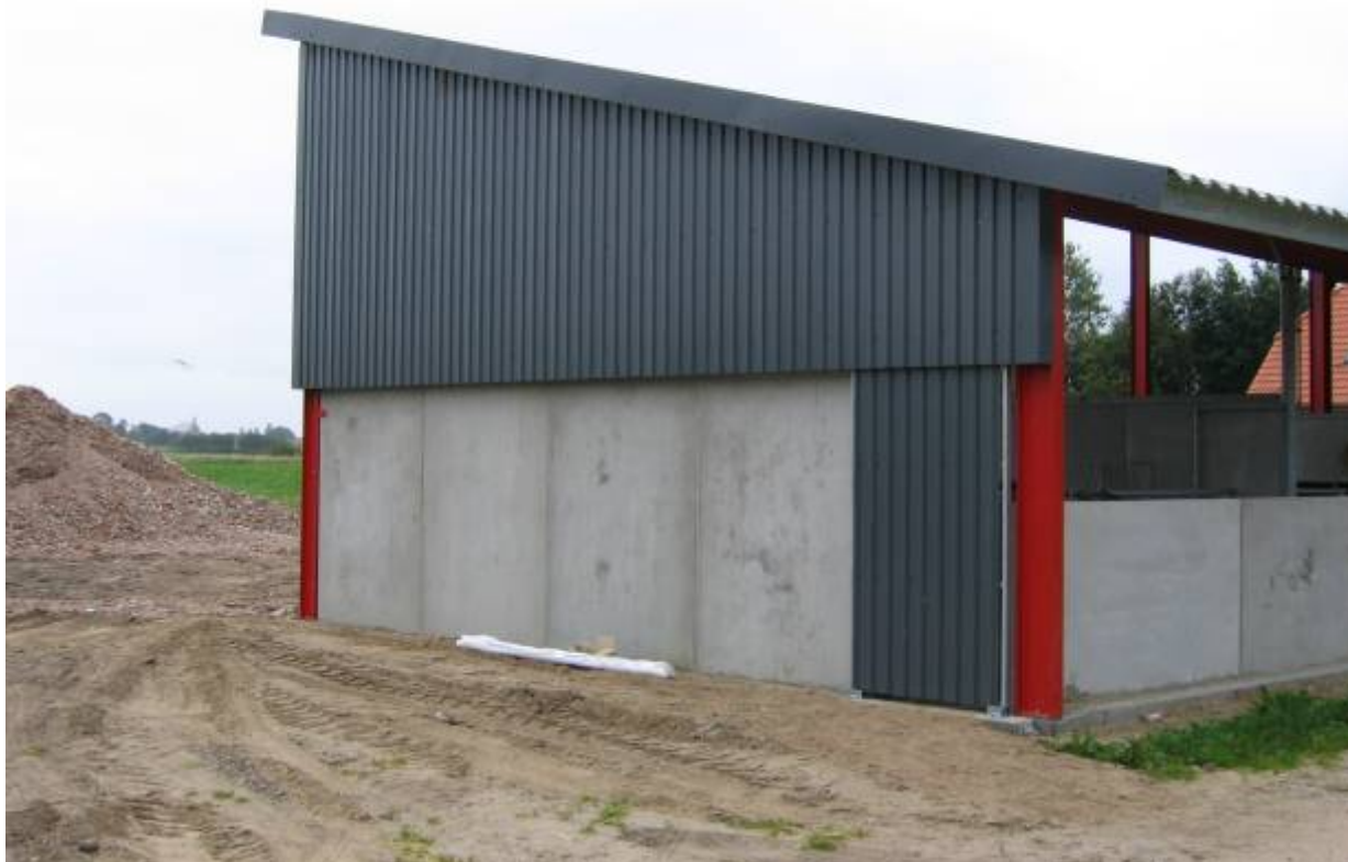
Den færdig Konzeptstalds facade mod nord.
