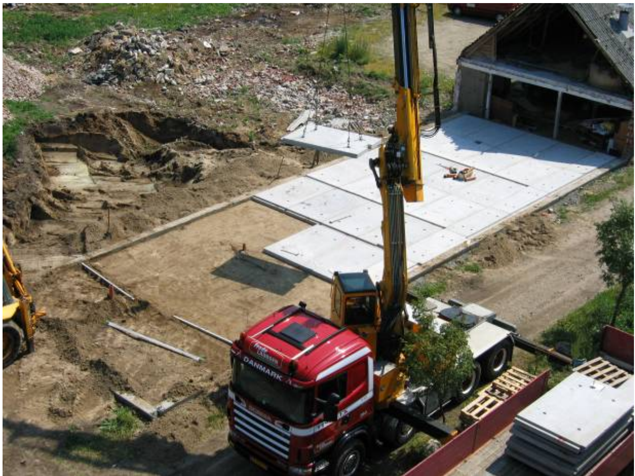
Gulvelementerne lægges ud med kran.
