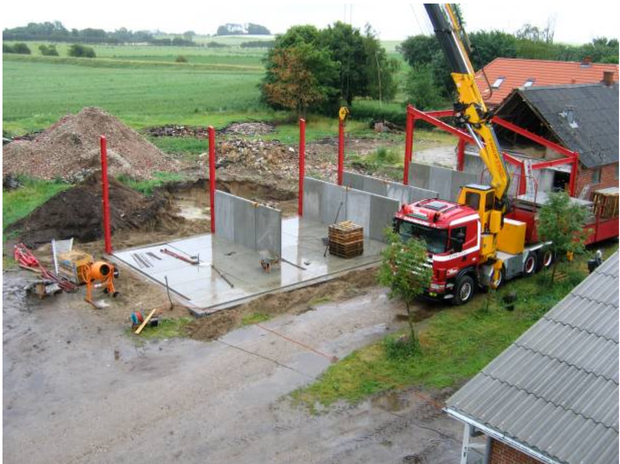
Herefter rejses vægelementerne. De står i en udsparring i gulvelementerne og fastgøres desuden til spærben og naboelementer. I første sektion monteres vindkryds.
