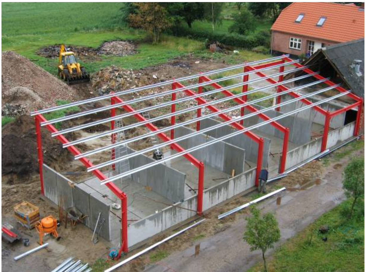
Åse monteres til sidst på 2. byggedag, for at stabilisere spærene.
