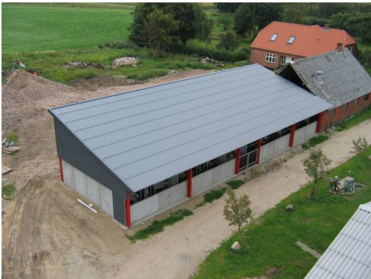
Taget færdiggøres på 12. byggedag. Gavle og døre i gavle beklædes med tyndpladestål.
