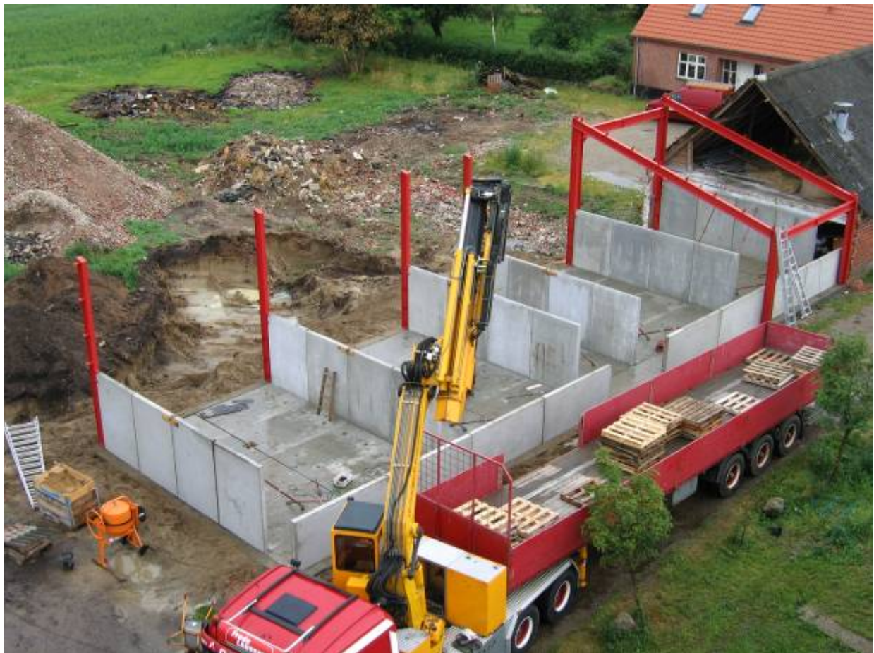
Anden del af spærene hejses på plads og fastspændes. Facadeelementerne, den lave mur mod vest, sættes på plads i deres udsparring.
