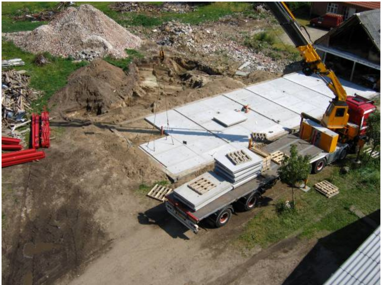
Gulvelementerne er et stort puslespil. Hver brik skal ligge helt præcist og er med til at holde de andre brikker på plads. Alle gulvelementerne blev lagt ud på 1. byggedag.
