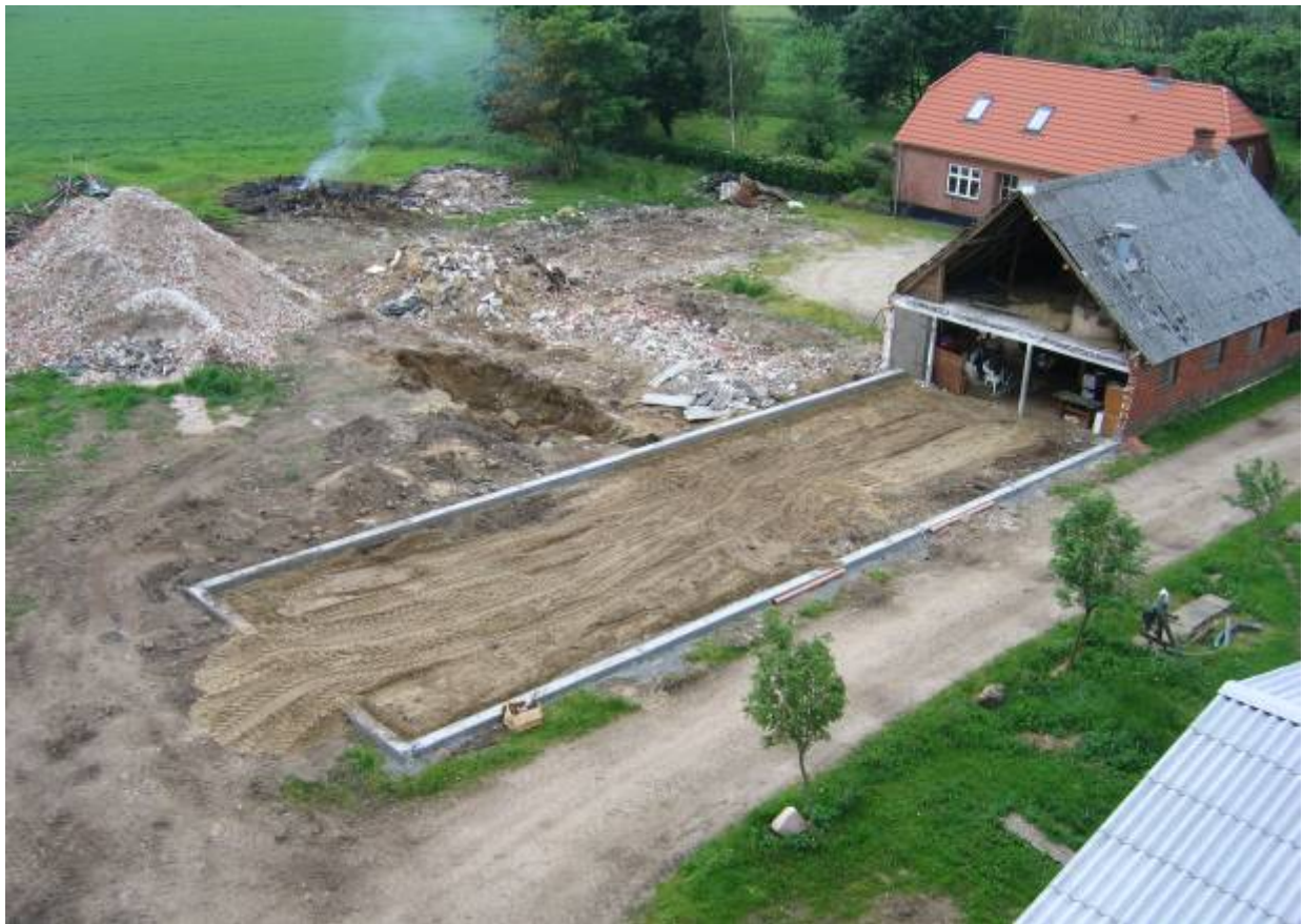
Fundamentet er støbt.
