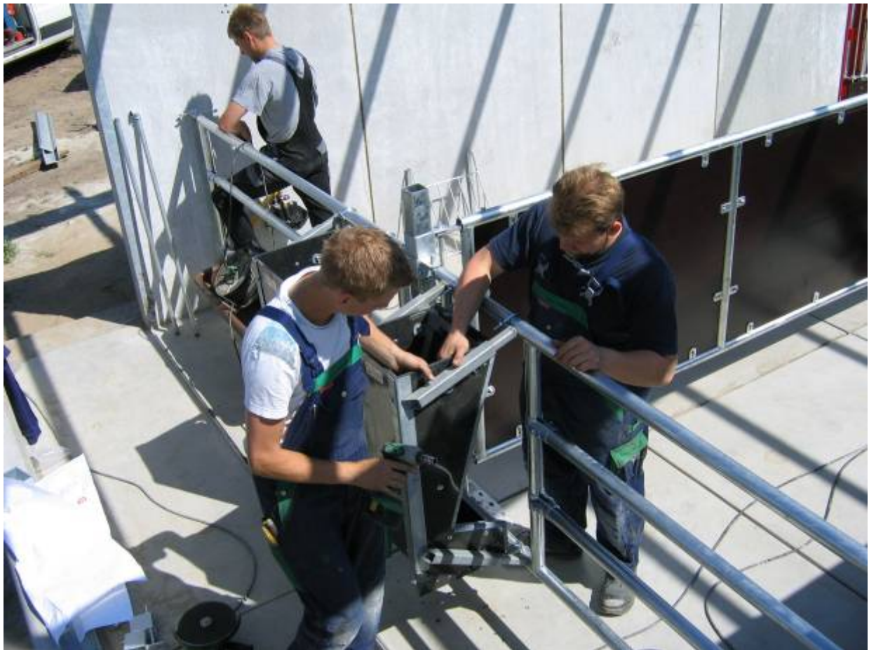
Montage af inventar i fællesbokse samt vandfremføring til drikkekopper
