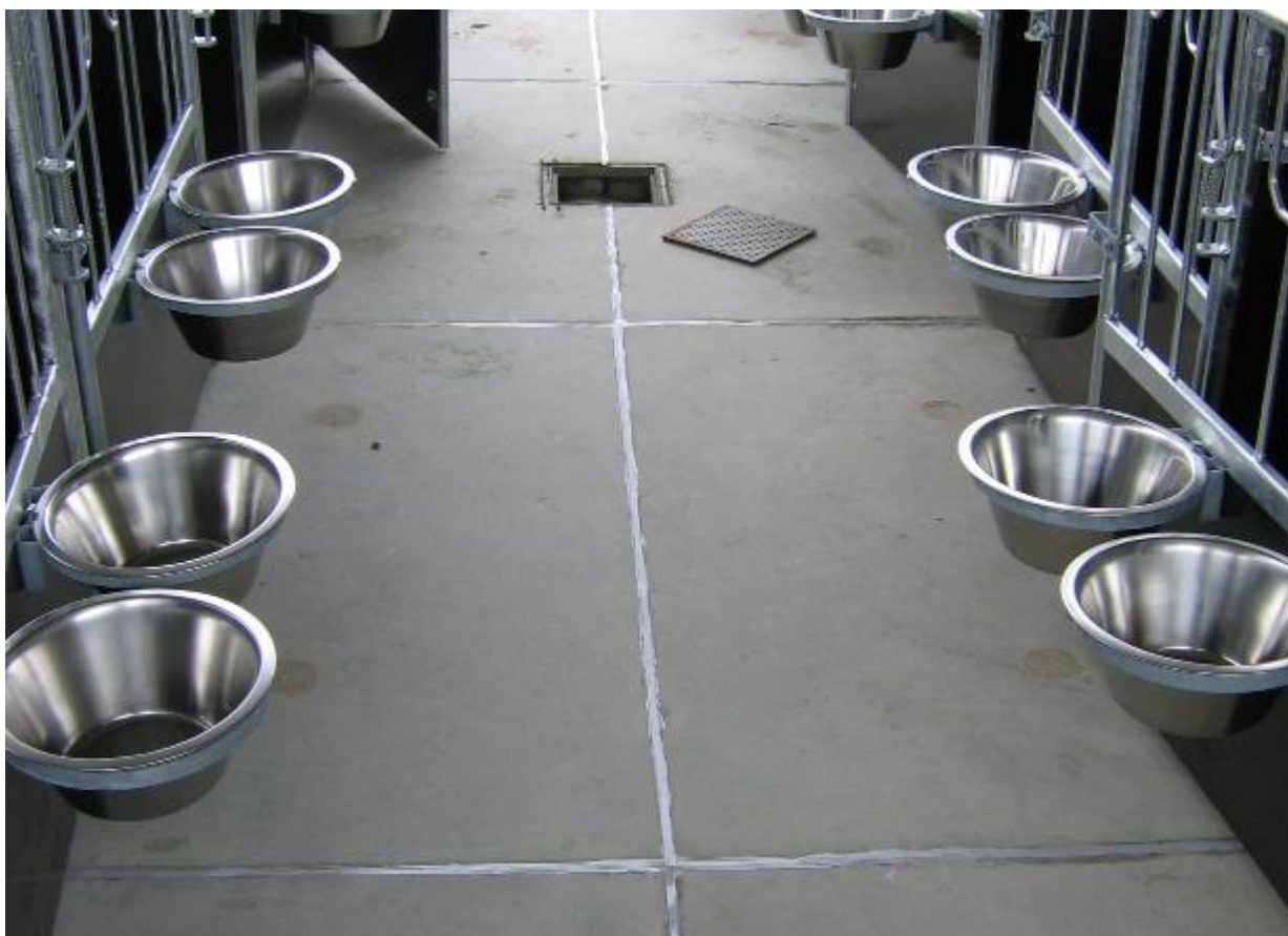
Alle gulvelementer er tætnet med gummifuge.
