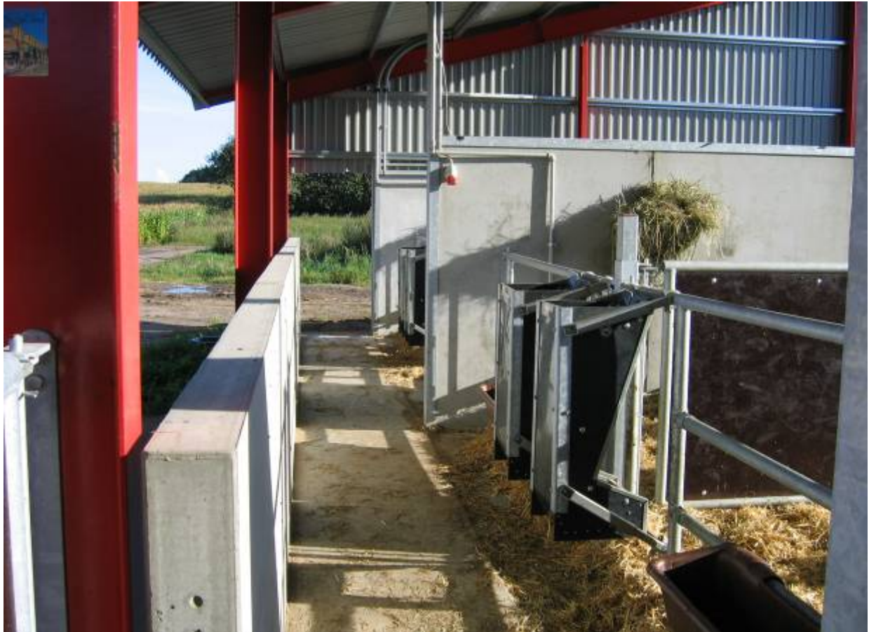
Et kig ned ad fodergangen med fællesbokssektioner til højre og lav facade mur til venstre.
