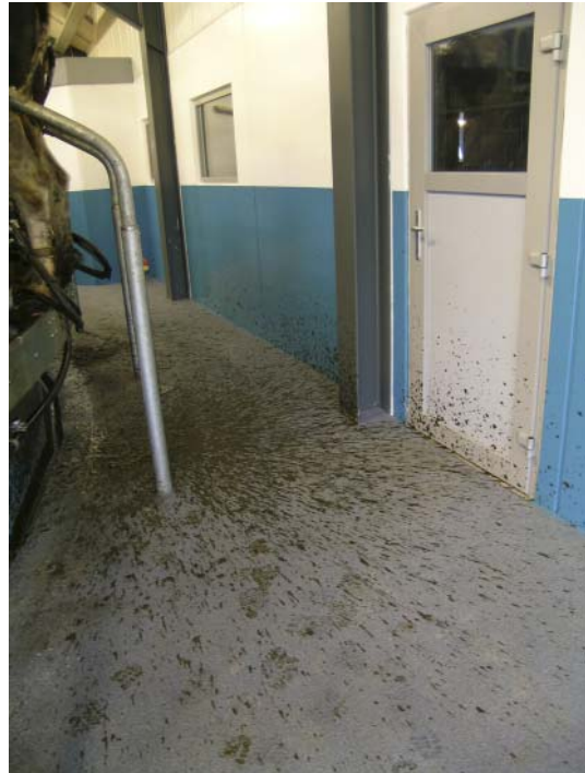
Figur 5.26. Køerne afsætter meget gødning på de sidste malkepladser inden udgang fra karrusellen, hvilket bevirker et større tidsforbrug til rengøring af området udenom malkekarrusellen.
