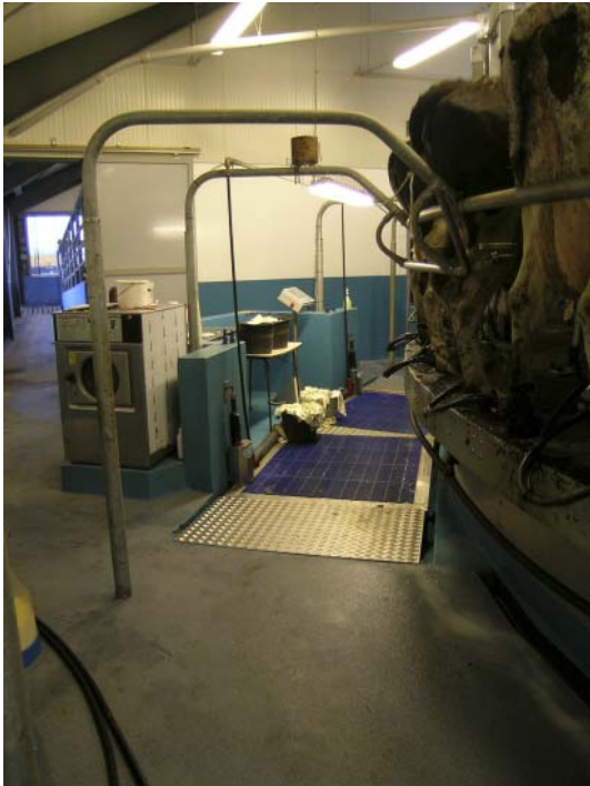
Figur 5.12. Eksempel på indretning af malkerens plads ved en udvendig karrusel. Der er regulært gulv, vaskemaskine, mindre spuleslanger, bord, hvor baljer til de rene klude stilles, ligesom der er baljer på gulvet til de beskidte klude.
