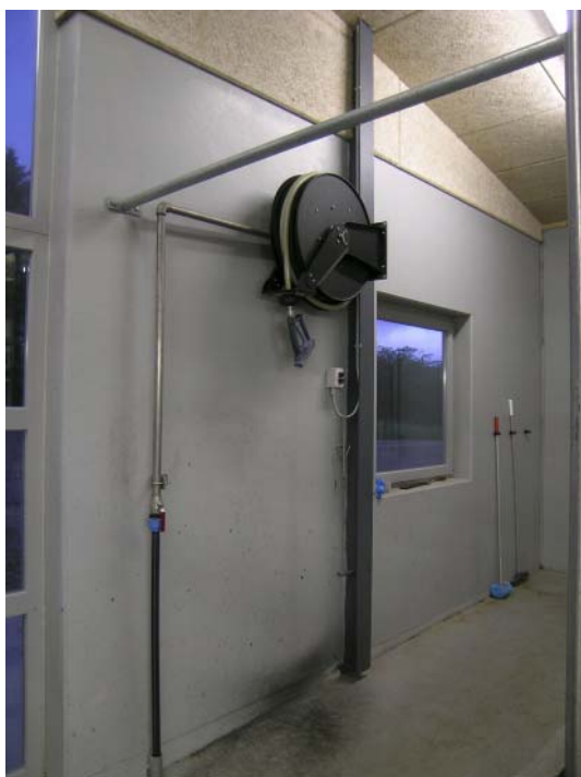
Figur 5.24. Spuleslange med automatisk slangeoprul på en tromle letter arbejdet frem for, at slangen ligger løst på gulvet.
