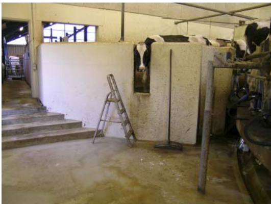
Figur 5.10. Der skal være gode adgangsforhold for malkeren til køernes udgangsparti, hvis for eksempel der er køer, som skal drives ud på returgangen. Her bør trappestigen udskiftes med en mere permanent og fast løsning.
