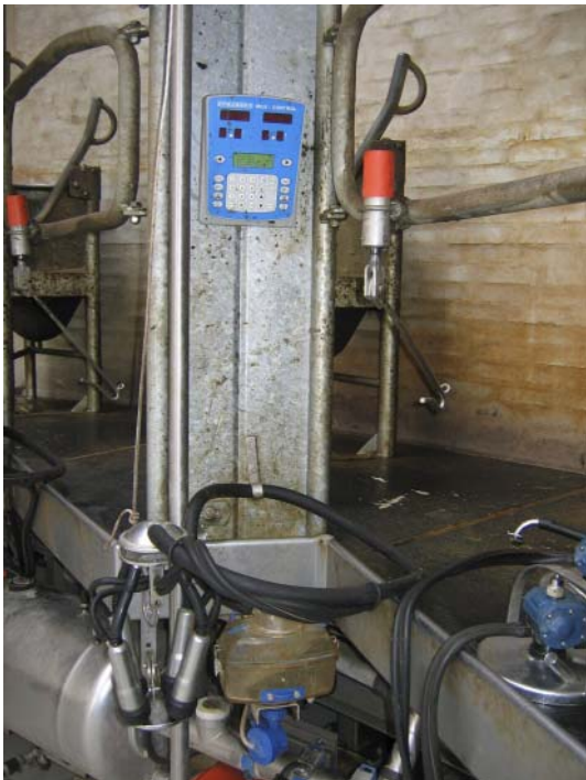
Figur 5.12. Eksempel på datadisplay til indtastning og aflæsning i malkestald fra Strangko.
