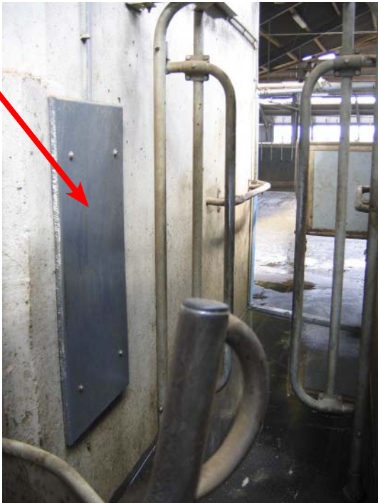
Figur 5.6. Eksempel på ringantenne fra Strangko, der er placeret ved indgangen til malkekarrusellen.
