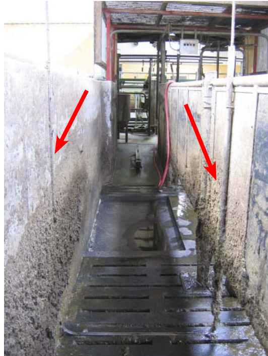
Figur 5.7. Eksempel på gennemgangsantenne fra Westfalia, der er placeret ved udgangen fra malkestalden umiddelbart før separationsenheden.
