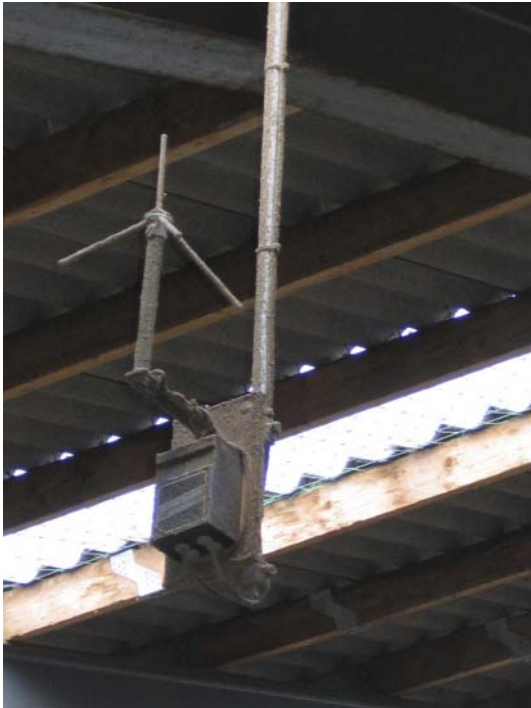
Figur 5.8. Eksempel på antenne centralt placeret under taget i stalden (fra DeLaval).
