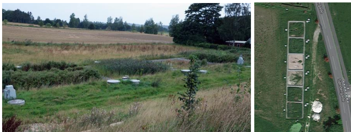
SupremeTech anlægget efter en årrække. Naturlig vegetation som dueurt, tagrør, dunhammer, pil og forskellige sumplanter har etableret sig. Foto Charlotte Kjærgaard. Ortofoto Orbicon
