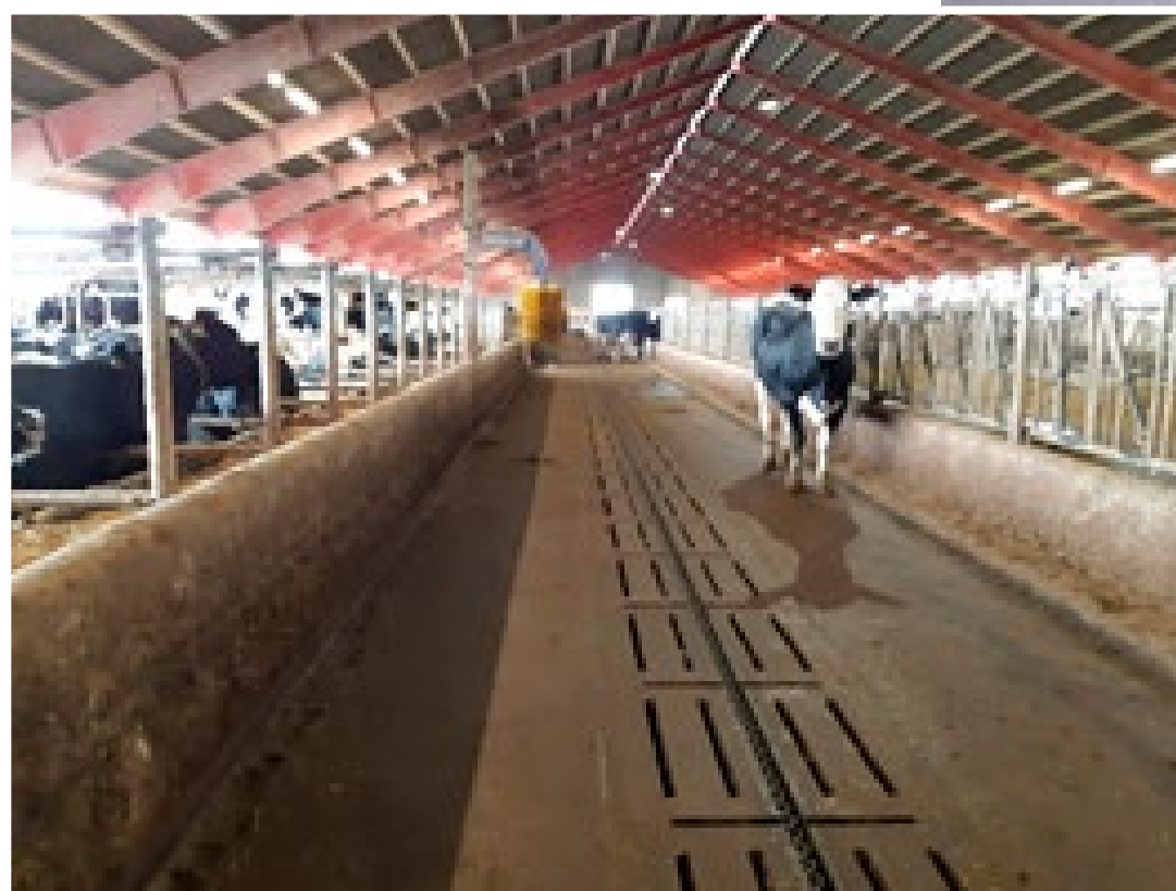
To typer af fast drænet gulv med skraber og ajleafløb. Foto: Anja Juul Freudendal
