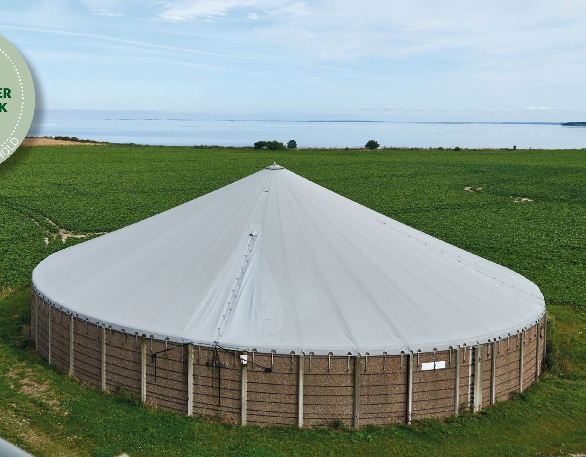
Overdækning af gyllebeholder. Foto: SEGES Innovation
