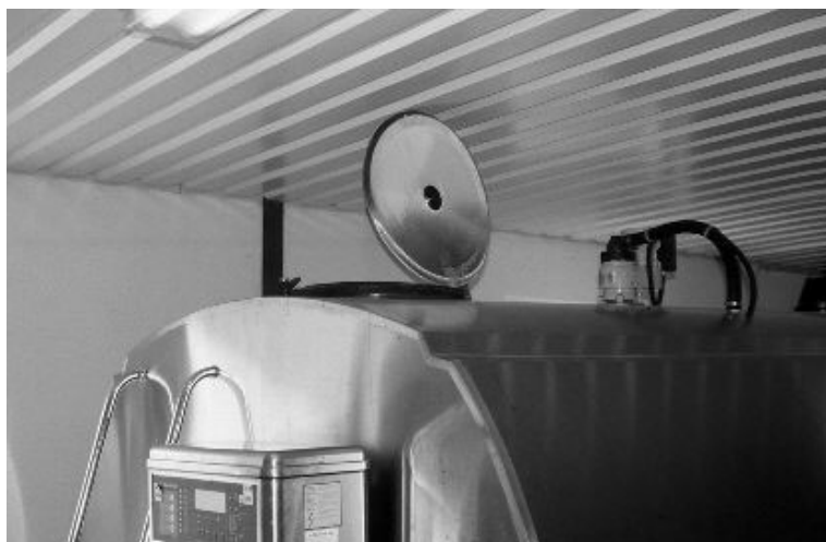
Figur 12: Uheldig fejl i mælkerum: Lågen øverst på mælkekøletanken kan ikke åbnes helt, da der er for lavt til loftet.
