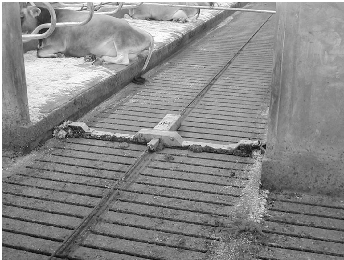
Linespilsanlæg med spalteskraber.
