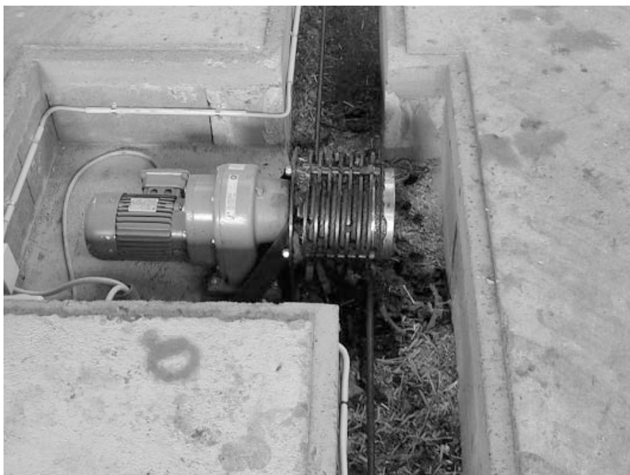
Trækstation med spiralføring
