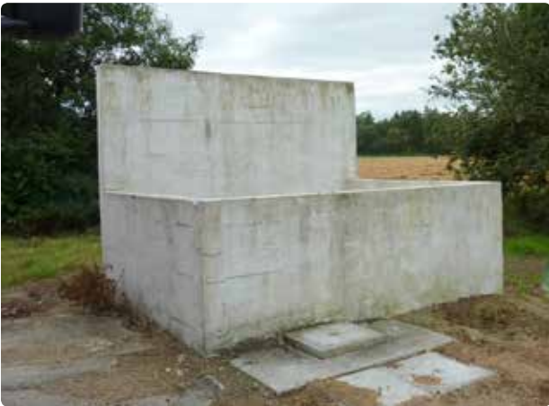
Figur 4.13. Kadaverkumme: 3,0 x 2,5 m, 1,2 m dyb og med en 2,4 m høj skyggemur mod syd. Opført i fundablokke. I bunden ligger spalter på en sandpude.
