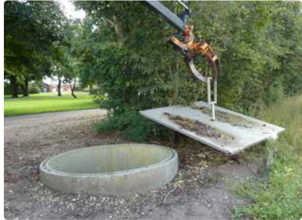
Figur 4.8. og 4.9. Hjemmelavet kadaverbrønd. En betonbrøndring, Ø300 cm – bredde 100 cm. Nedgravet 70 cm, dvs. 30 cm over jorden. Låget, der er hjemmelavet, består af en ramme i rustfrit stål med aluminiums dørplader, for at den ikke skal blive for tung, samt en løftring.
