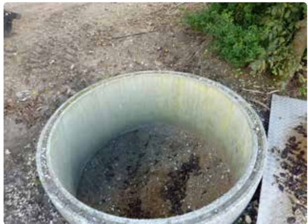
Figur 4.10. og 4.11. Nedgravning med høj kant forhindrer at regnvand løber ned i brønden og sikrer samtidigt, at temperaturen i brønden er lavere på varme dage, end hvis den ikke var nedgravet. Betongsplinter i bunden vil give ventilation under dyrene og dermed fuldende løsningen.
