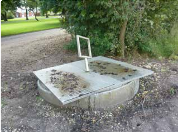
Figur 4.8. og 4.9. Hjemmelavet kadaverbrønd. En betonbrøndring, Ø300 cm – bredde 100 cm. Nedgravet 70 cm, dvs. 30 cm over jorden. Låget, der er hjemmelavet, består af en ramme i rustfrit stål med aluminiums dørplader, for at den ikke skal blive for tung, samt en løftring.
