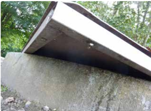
Figur 4.10. og 4.11. Nedgravning med høj kant forhindrer at regnvand løber ned i brønden og sikrer samtidigt, at temperaturen i brønden er lavere på varme dage, end hvis den ikke var nedgravet. Betongsplinter i bunden vil give ventilation under dyrene og dermed fuldende løsningen.
