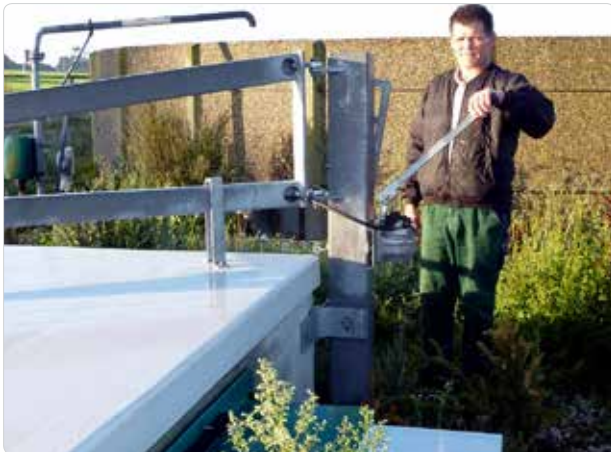
Figur 4.23. Kølebrønden åbnes ved at pumpe med et håndtag, så låget løftes lidt, derefter skubbes låget til side.
