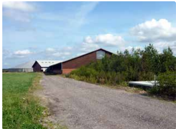
Figur 4.21. Valg af placering er ekstra vigtig, når det er en kølebrønd som opstilles, da den jo ikke er så let at flytte rundt med. Her meget diskret et stykke fra landevejen, ad en bagvej til ejendommen, hvor der kun sjældent er anden færdsel.
