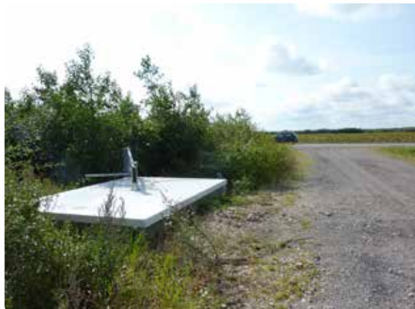
Figur 4.25. og 4.26. En meget diskret placeret kølebrønd ved bagindkørslen til staldanlægget. Dakabilen bakker ned ad vejen og kommer derved ikke nærmere staldene end kølebrønden.
