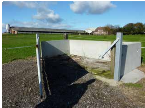
Figur 4.15. Afhentningssted på 2 x 4 m, opført med spalter i bunden på en sandpude og præfabrikerede betonelementer som sider. Element/låge mod syd bør være højere (dog maks. 1,4 m) for at give skygge på kadaverpladsen, og samtidig let adgang for Dakabilens kran.
