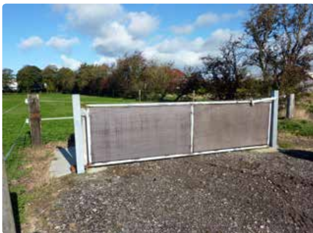
Figur 4.16. og 4.17. En stor låge i hele opbevaringspladens længde på 4 m, giver let adgang ved fyldning, samt for chaufføren, når der skal klippes/scannes øremærker. Af hensyn til forbigående i høje køretøjer, fx busser og lastbiler, bør kadaverne på afhentningspladsen overdækkes.
