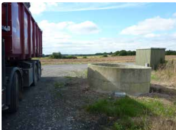
Figur 4.12. Flere betonrør oven på hinanden, så bliver der mere plads i brønden.
