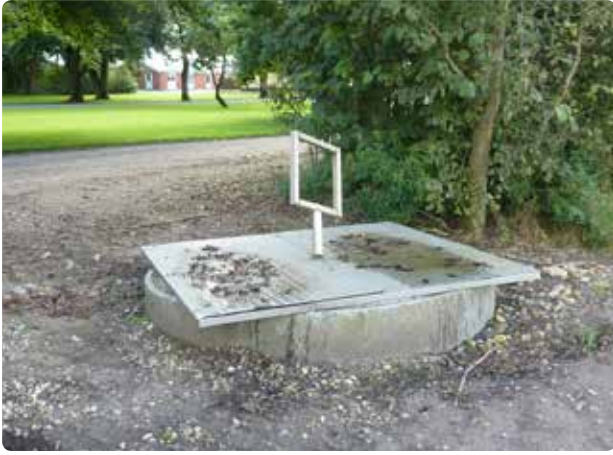
Figur 1.2. Nedgravet brøndring med låg.
