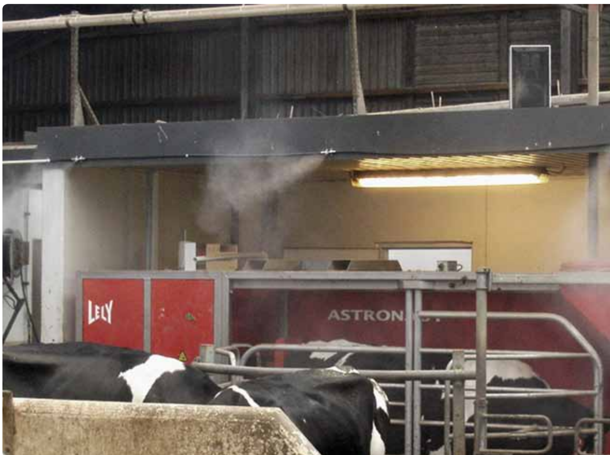
Billede 13. Højtrykskøling ved robotten.
