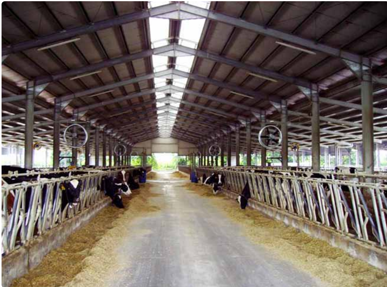
Billede 11. Blæser med højtryksskøling over foderbord.
