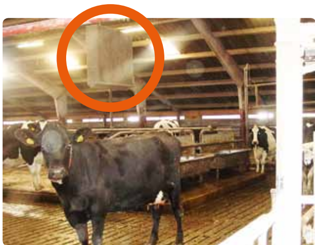
Billede 4. Kontrolstalden har vertikale ventilatorer.
