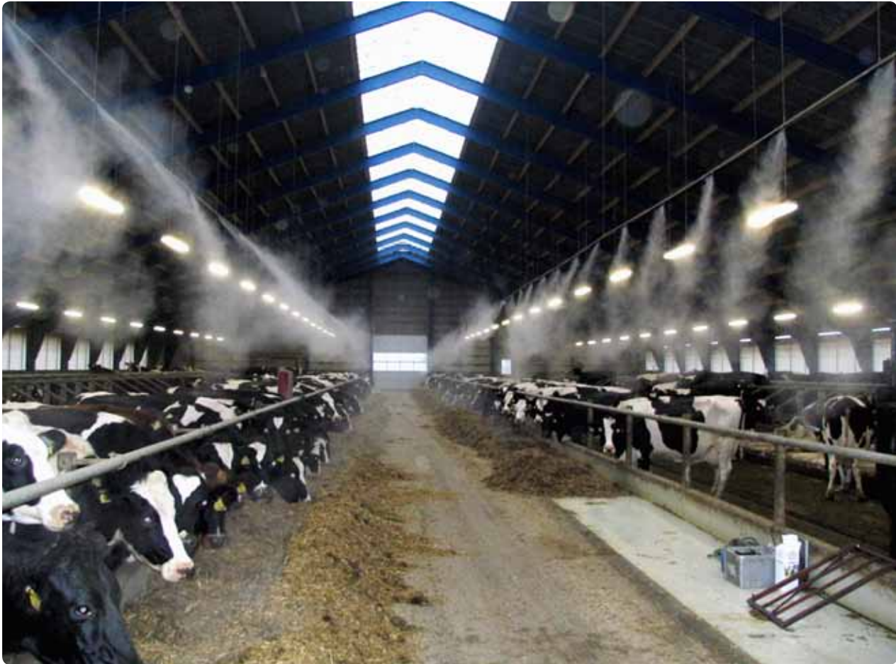
Billede 10. Højtrykskøling over foderbord.
