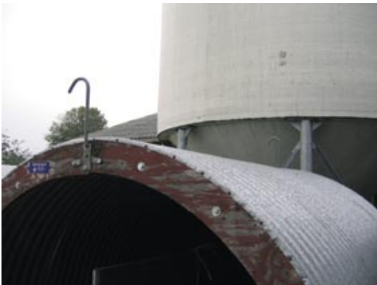
Figur 4 - Kroege på taget af "Kalvehytte (Spøttrup Hytten)" til flytning med for eksempel frontlæsser.
