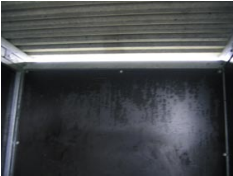
Figur 1 - Ventilationsåbning bagerst foroven i hver enkeltboks "Kalveexpres".
