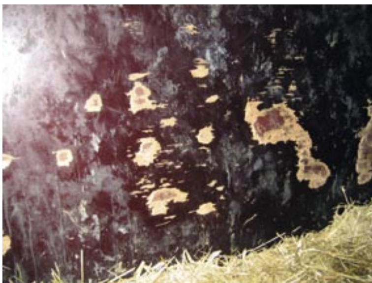
Figur 6 - Skader på bokssider i ældre mobilhytte fra CN Agro (2001).
