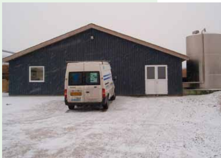
Figur 5.2. (Øverst) Gavl, hvor stålplade er ført til terræn. Indvendigt er der en 1 meter høj betonmur, hvor der går dyr.
