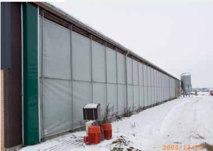
Figur 5.22 (Nederst) Sydsiden med gardiner i hele siden. Fem meters væghøjde.
