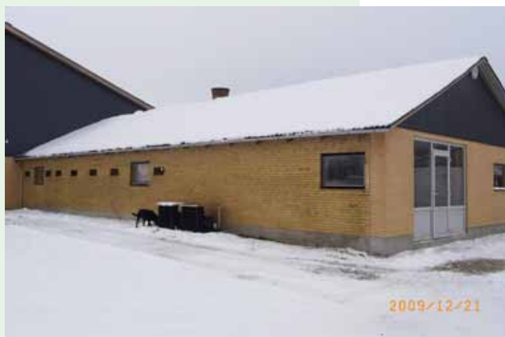
Figur 5.19 (Øverst) Robotter i isoleret robothus, resten af stalden er uisoleret.
