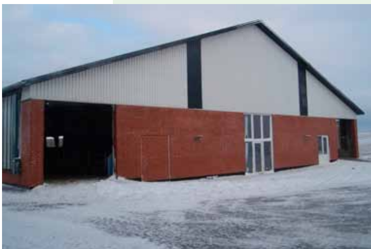
Figur 5.16. Facade ved malkecenter opført udvendigt i røde teglsten og indvendigt i lecablokke. Gavltrekanter i stålplader.
