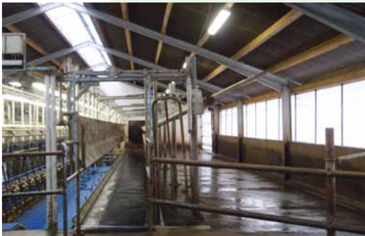
Figur 1.3. En 2x25 pladsers 'side by side' malkestald med 'fast exit' i særskilt, uisoleret bygning.
