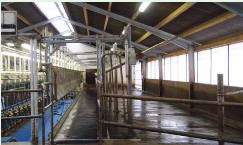
Figur 1.3. En 2x25 pladsers 'side by side' malkestald med 'fast exit' i særskilt, uisoleret bygning.
