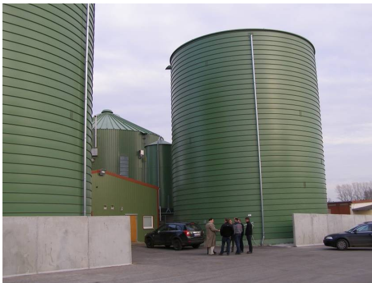
Figur 32. Vandtætte stålsiloer med formalet majs med 50 % vand.
