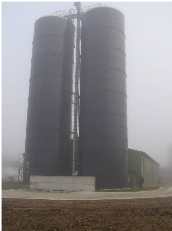
Figur 24. 25 m høje gastætte siloer med majs med 35 % vand.
