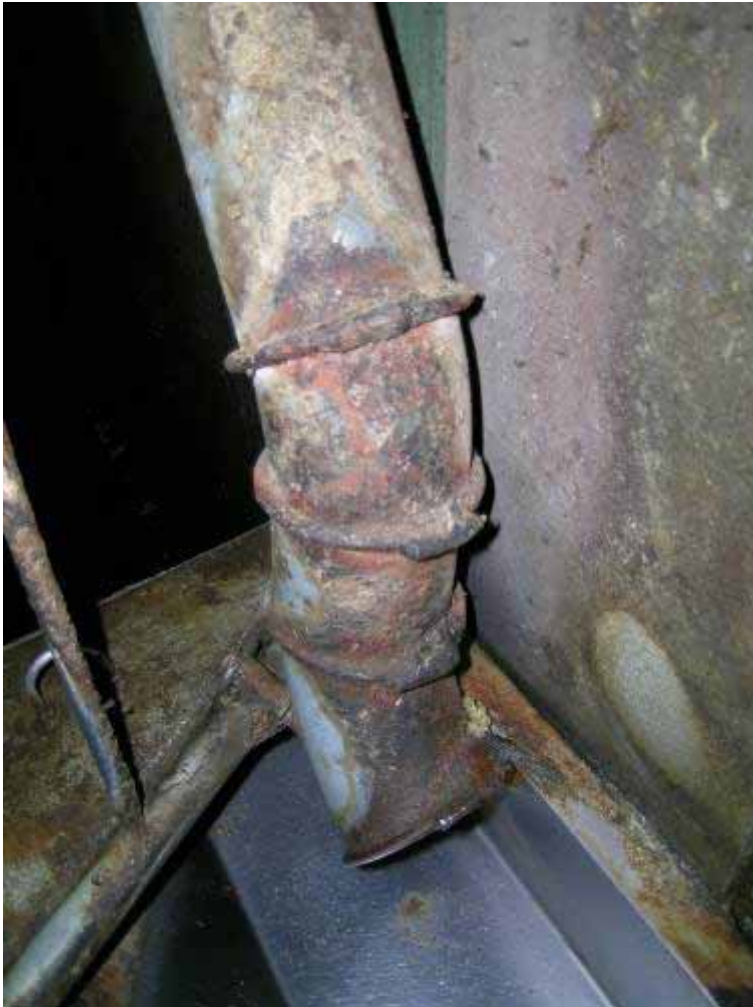
Figur 16.3. Udfodringen sker via et stålrør. Udformning og placering er tilfredsstillende, men overfladebehandlingen er for dårlig. Der kan desuden ligge foderrester på trugets kanter omkring røret.
