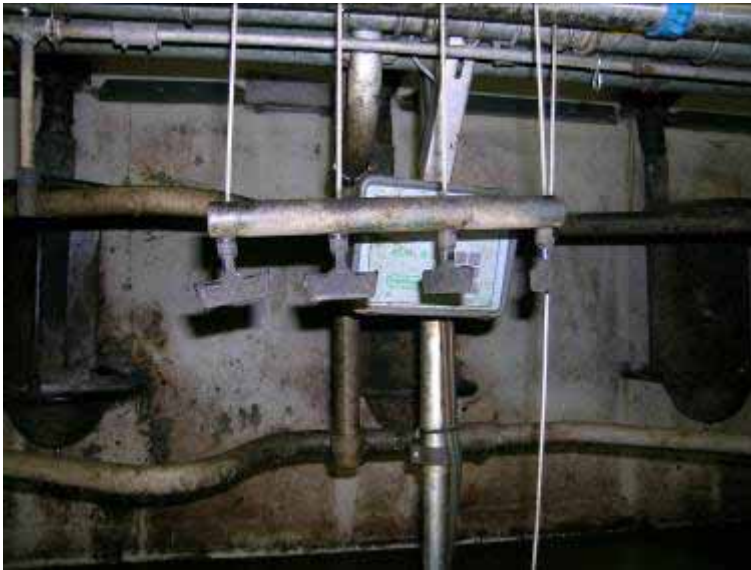
Figur 17.2. Betjeningen foretages fra malkegraven, hvor udfodringen sker via håndtag. Den tværgående pind muliggør udfodring i fire automater samtidig.
