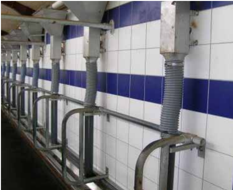
Figur 15.3. Udfodringen sker via plastrør. Udformning og placering er meget tilfredsstillende, men holdbarheden kunne være bedre. (beskær billede med fokus på plastrør).
