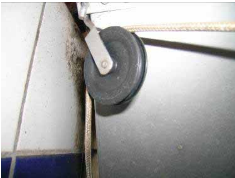
Figur 15.4. Forbindelsen fra udløserhåndtagene til automaterne sker via snore og trisser. Et simpelt men effektivt princip uden overflødige komponenter. Alt er i rustfri materialer.
