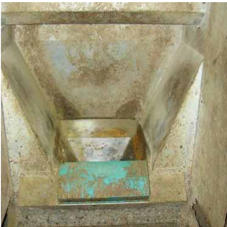
Figur 12.3. Transponderen udløser foder, når koen kommer i nærheden af truget. De høje kanter nedsætter foderspildet. Der er ingen flader, hvor foderet kan ophobe sig, men selve truget er kantet i bunden, hvor foderet vil sætte sig.
