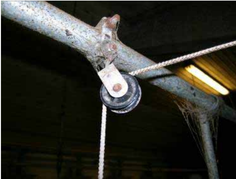
Figur 16.4. Forbindelsen fra udløserhåndtagene til automaterne sker via snore og trisser. Et simpelt men effektivt princip uden overflødige komponenter. Bolte og møtrikker burde være rustfri.
