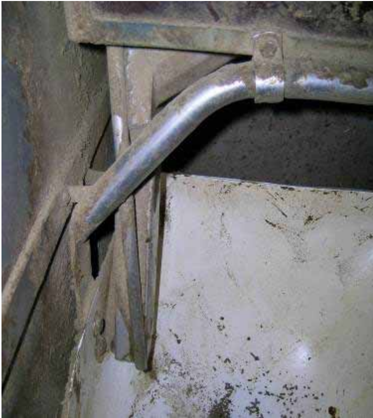
Figur 5.3. Udfodringsrøret er firkantet, hvilket medfører, at urenheder lettere kan sætte sig i hjørnerne i forhold til et rundt rør. Der er dog ingen tendenser til, at røret stopper til.
