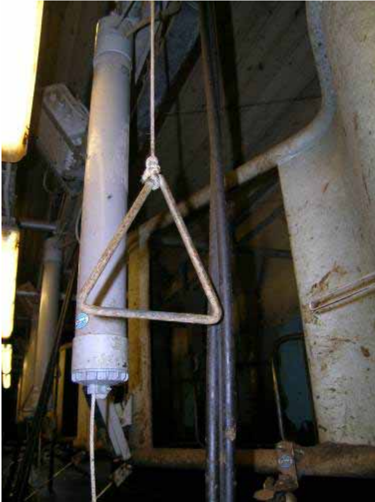
Figur 16.1. Foderet udfodres ved at trække i håndtaget, som er forbundet til automaten.
