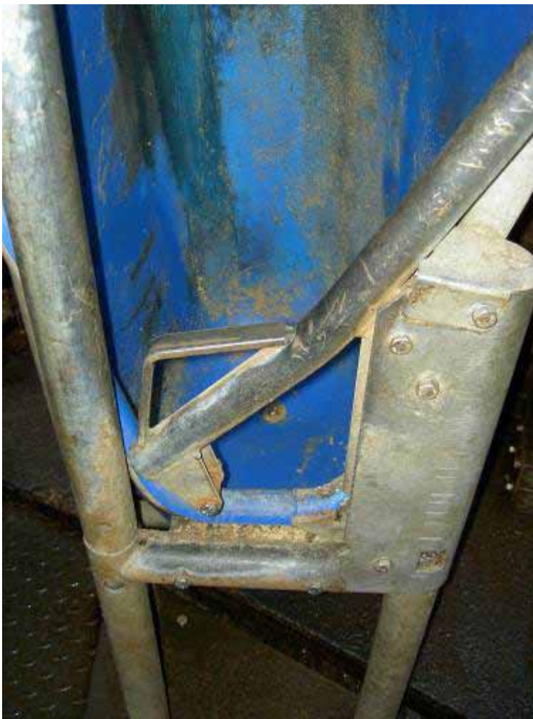
Figur 10.2. Krybben er rengøringsvenlig og godt udformet uden kanter og sprækker. Fanggitteret er derimod ikke optimalt indrettet. Her er slidmærker mange steder, som tegn på at koen ikke står som den skal.
