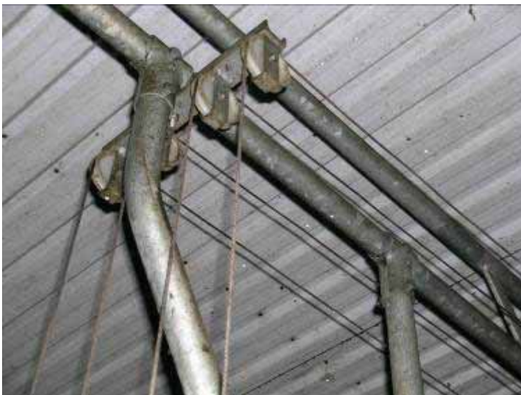
Figur 17.3. Forbindelsen fra udløserhåndtagene til automaterne sker via snore og trisser. Et simpelt men effektivt
