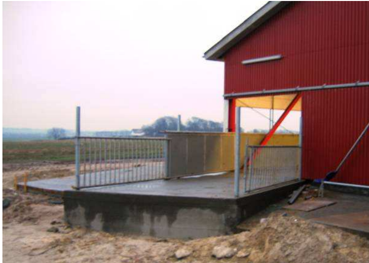
Figur 16. Udleveringsrampe - kalvene går vandret ud af stalden og vandret ind i lastbilen, niveauforskellen udnyttes.
