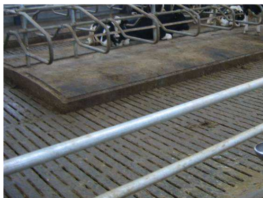
Figur 9. Velfungerende og rent spaltegulv i sengebåsestald.
