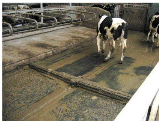
Figur 10. Fast gulv med gummi og skraber - som pga. store driftsproblemer ikke fungerede tilfredsstillende.
