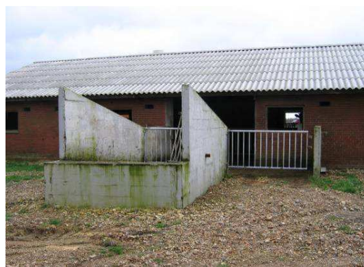
Figur 15. Udleveringsrampe – kalvene går op ad rampen og lige ind i lastbilen.
