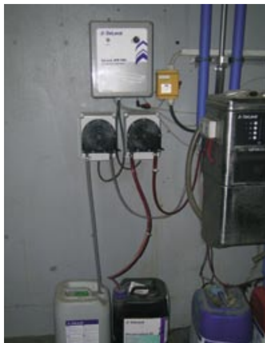
Figur 7.2: Al påfyldning og tømning foregår automatisk. Der kan påfyldes et eller to midler, her sæbe eller hoofcare. Interval og mængde kan justeres individuelt.
