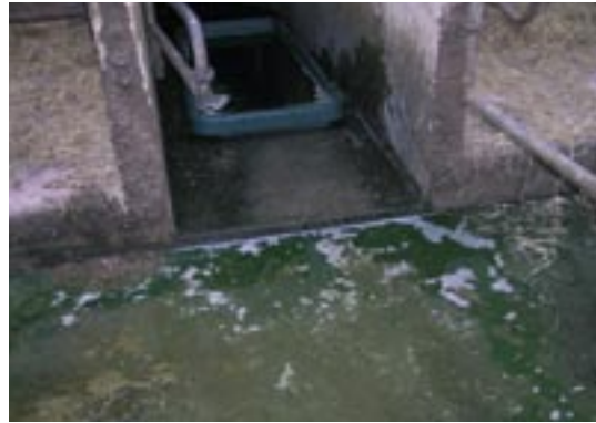
Figur 5.4: Returgangen har et lille fald. Det medfører et stort væskespild fra karret, idet det står skævt. Bemærk væsken på gulvet hvor det ikke gør meget gavn. Tværtimod er kobbersulfaten meget hård ved beton og inventar.
