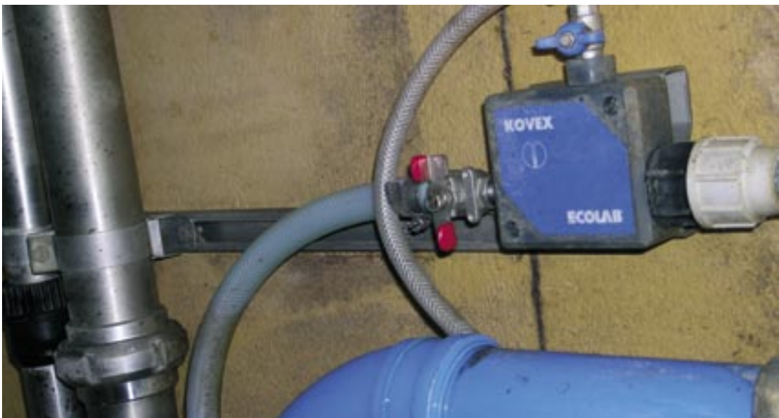
Figur 9.3: Betjeningen foregår fra malkestalden ved hjælp af to håndtag på boksen. Det kræver lidt øvelse at dosere skummet, så det opnår den rigtige konsistens.
