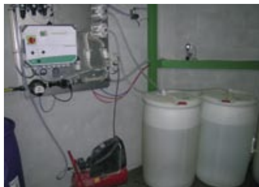
Figur 8.2: Der kan påfyldes to midler. Her sæbe og desinficerende klovsplejemiddel. Interval og mængde kan justeres individuelt. Styringsenheden og klovsplejemidler er gemt væk i teknikrummet. Kompressoren driver påfyldnings- og tømningsmekanikken, som er pneumatisk.
