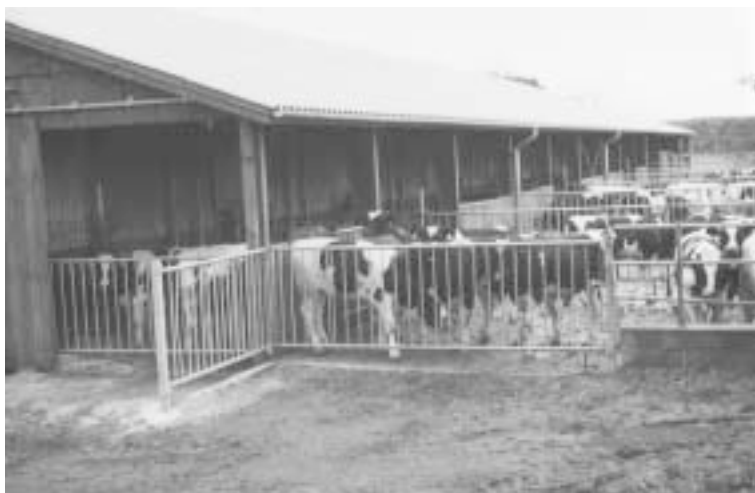
Figur 5.24 Løbegårde og udendørs overdækket ædeplads ved ungtystalden.
