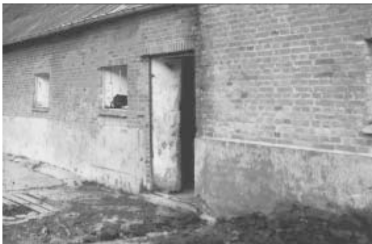
Figur 5.18 Spalteareal til opsamling af gødning med mere fra løbegården ses til venstre i billedet. Til højre er døren ind til ungvægstalden.
