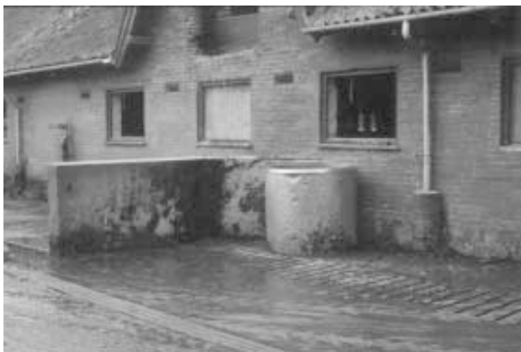
Figur 5.11 Inde ved muren ses spaltekanal til gødningsopsamling fra løbegården. Bemærk hvordan nedløbsrørene er beskyttet af halve olietønder fyldt med cement.
