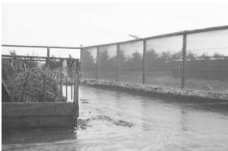
Figur 5.9 I løbegårdens østside er der opsat vindbrydende net i rammer af el-master. På indersiden er opsat el-tråd.
