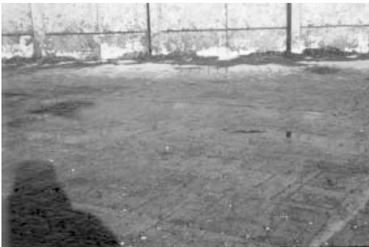
Figur 5.3 Profileret betonbund i løbegården.
