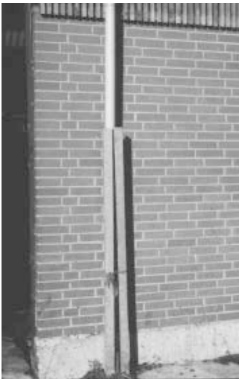
Figur 5.5 Nedløbsrør i løbegården beskyttet af vinkeljern.
