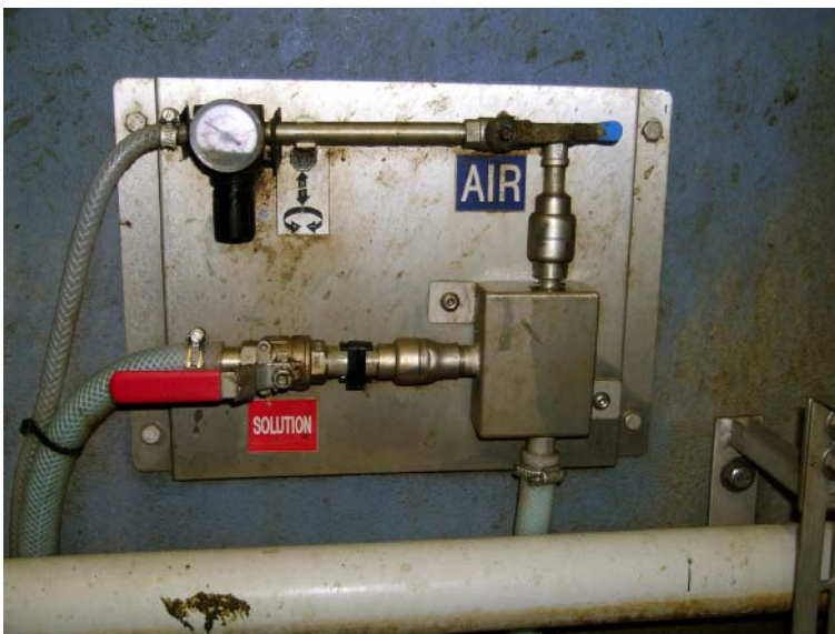
Figur 18. Betjeningen foregår fra malkestalden ved hjælp af to håndtag. Det kræver lidt øvelse at dosere skummet, så den opnår den rigtige konsistens.
