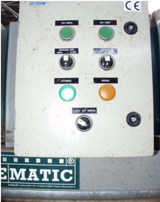
Figur 16. Betjeningspanelet på Carematic-boksen fungerer fint. Desværre kan køerne aktivere startsensoren inde i boksen udefra. Det bevirker, at der ofte behandles uden ko i boksen med spild af klovsplejemiddel til følge.
