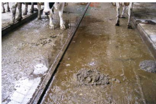
Figur 27. Gulvet her er meget gødningstilsmudset og fugtigt, hvilket giver klovsygdommene gode vilkår. Løsningen her kan være flere skrabeintervaller pr. døgn for at fjerne gødningen.
