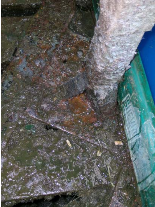
Figur 33. Her ses et eksempel på kobbersulfatens påvirkning på inventaret. Der kan forventes en reduceret levetid på metal som jævnligt påvirkes af syre.
