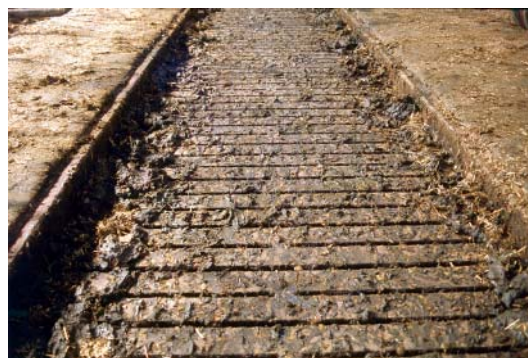
Figur 28. Kotrafikken er ikke altid tilstrækkelig stor til at holde spaltegulvet rent. Her skal der rengøres manuelt med håndskraber eller skrabemaskine.
