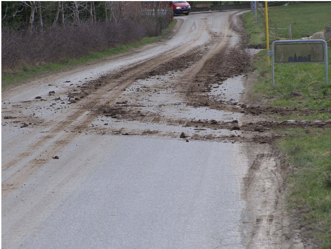
Forurening af vej er vanskeligt at undgå, men der skal senest ryddes op ved arbejdstids ophør. Foto: Jens J. Høy, AgroTech.
