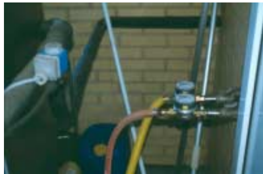
Figur 11. Vandurene til måling af forbrug på køletanken.
