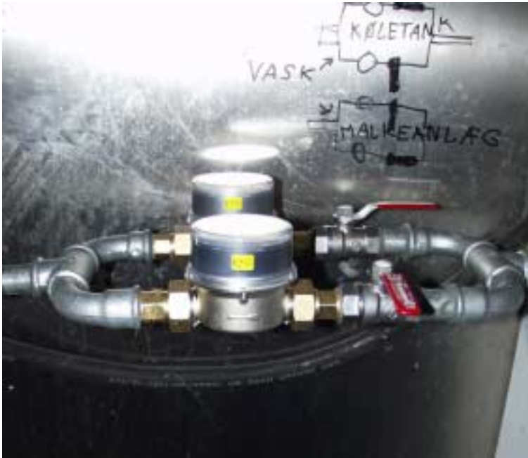
Figur 6. Vandure til måling af forbrug på CIP.
