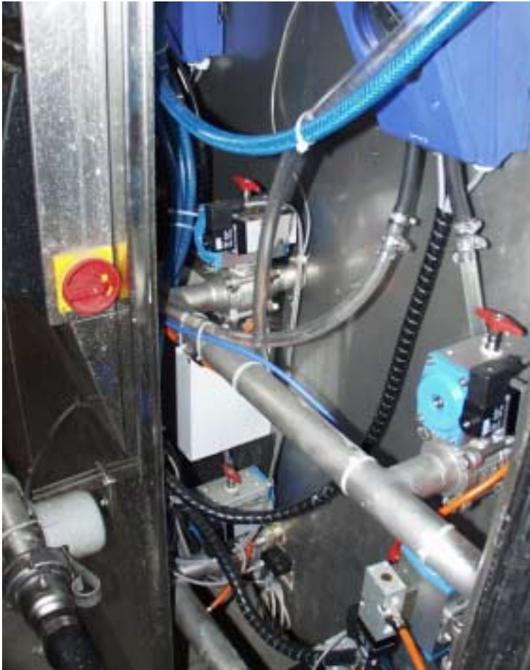
Figur 17. Teknikken i CIP-anlægget er mere kompliceret end på det konventionelle anlæg.
