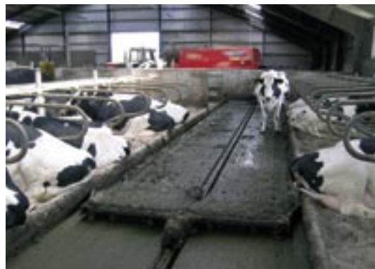
Figur 3.4: Præfabrikeret drænet gulv.
