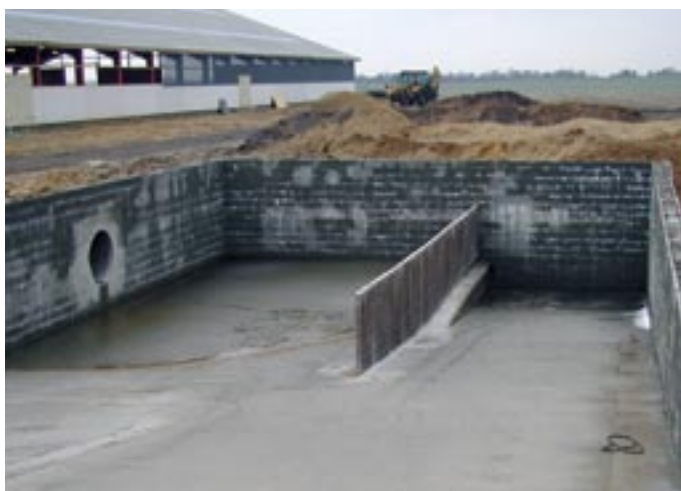
Figur 2.4 Sandfang med to kamre. Sandet skal bundfælde i kammer til højre, mens den tynde del pumpes væk fra kammer til venstre (Rasmussen og Raun, 2000).
