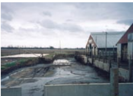
Figur 2.3: Eksempel på typiske amerikanske laguner med nedkørselsrampe placeret for enden af staldene.
