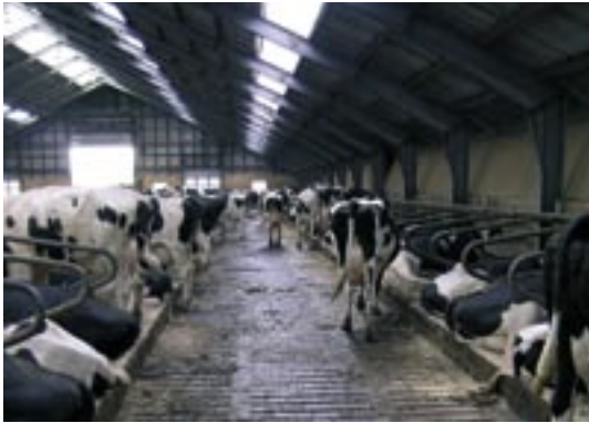
Figur 3.1: Spaltegulv, 0,4 meter dybe kanaler med linespilanlæg.
