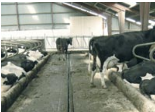
Figur 3.3: Fast pladsstøbt betongulv med dræn.
