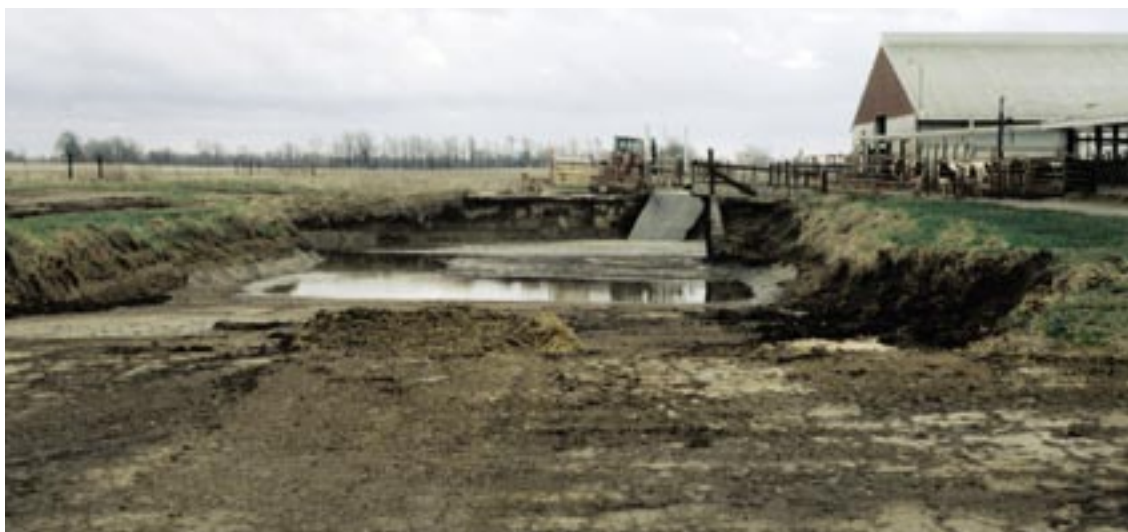
Figur 5.8: Sandfang med rampe til bundfældning af sand.
