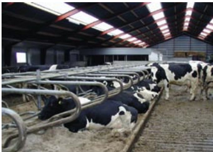
Figur 2.1: Løsdriftstald med sand i sengebåse og spaltegulv (Rasmussen og Raun, 2000).
