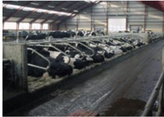
Figur 3.2: Fast pladsstøbt betongulv med profilering og uden dræn.
