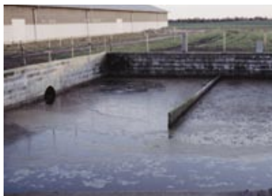
Figur 2.3: Eksempel på typiske amerikanske laguner med nedkørselsrampe placeret for enden af staldene.
