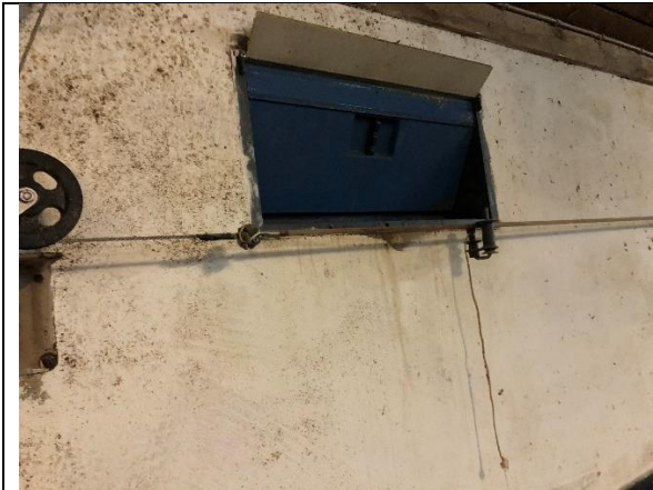
Figur 1. Vægventil før montage af ventilklap.
