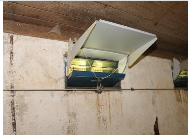
Figur 2. Vægventil efter montage af ventilklap.
