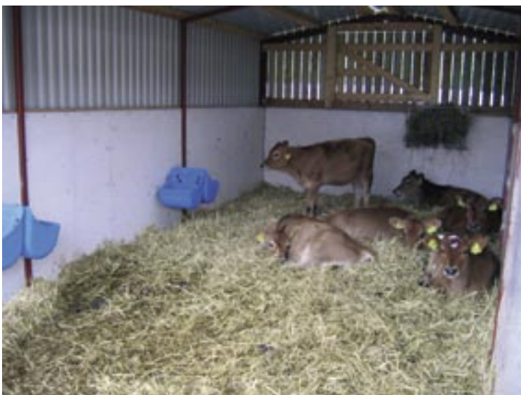
Figur 2 - Plastbeklædning på indersiden af "Kalvehytte".
