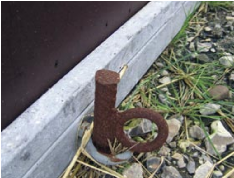
Figur 6 - Spyd, der holder hytte på plads, kan eventuelt også benyttes til fastmontering af "støttenet" i midten af frontgitteret.
