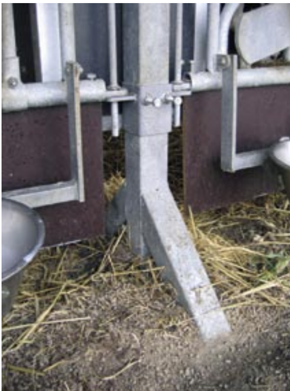
Figur 5 - Ekstra "støtteben" på midtsøjlen i frontgitteret.
