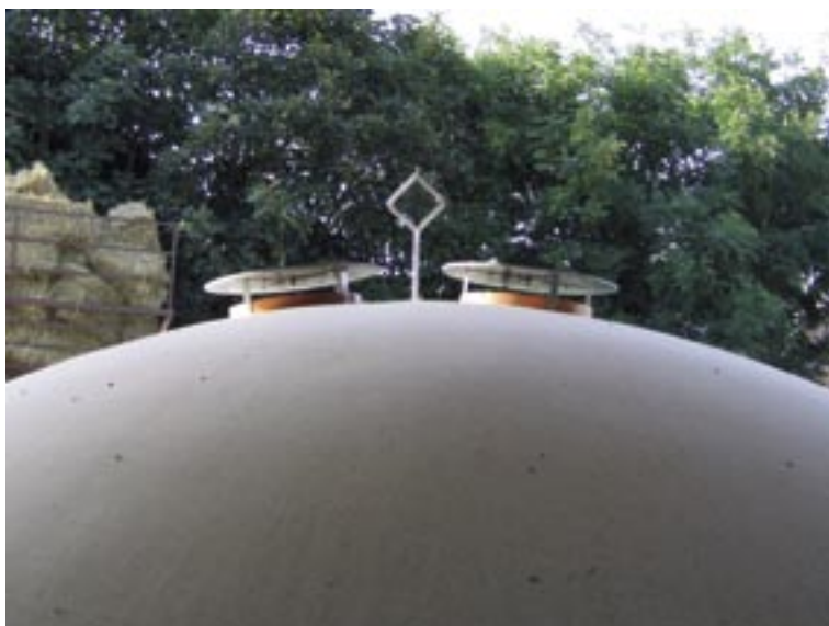
Figur 2 - Løfteanordning og to (af fire) ventilationshuller på taget af "Holm & Laue Iglu".
