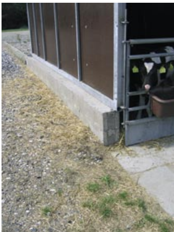
Figur 2 - Betonelementer under "Kryb i ly" forbedrer luftskiftet og beskytter hytten ved udmugning.
