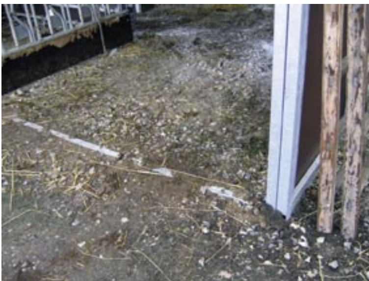
Figur 7 - Niveauforskel mellem "Countryhyttes" bundramme og det anlagte grusunderlag.
