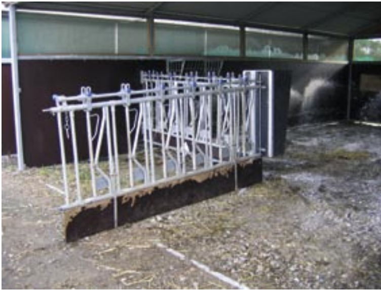
Figur 4 - Skader på indersiden af frontgitteret.
