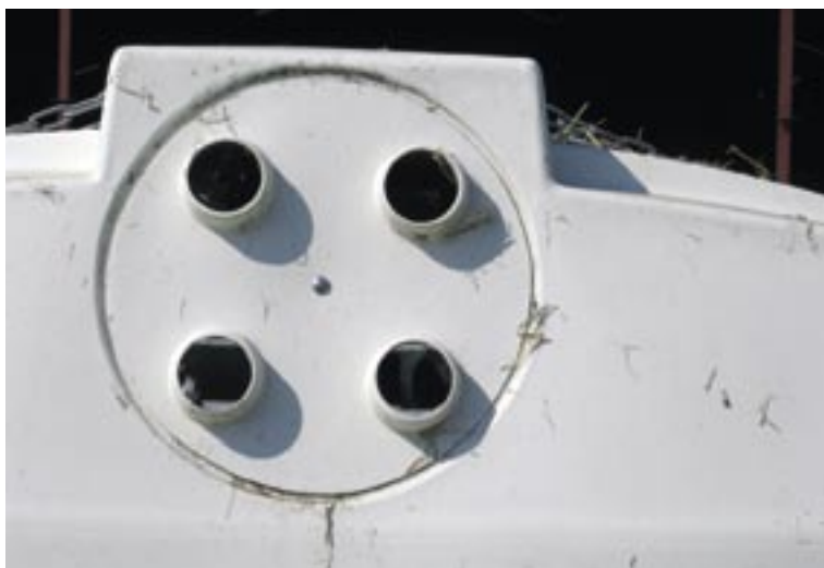
Figur 1 - Ventilationsåbning bagrest i "Agri Plastics fælleshytte".
