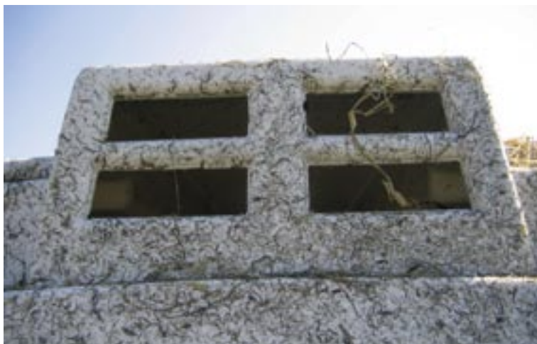
Figur 2 - Ventilationsåbning forrest i "Agri Plastics fælleshytte".
