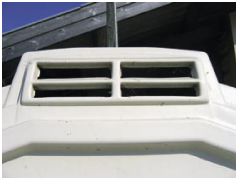
Figur 1 - Ventilationsåbning for enden af tagryggen i "Multimax".
