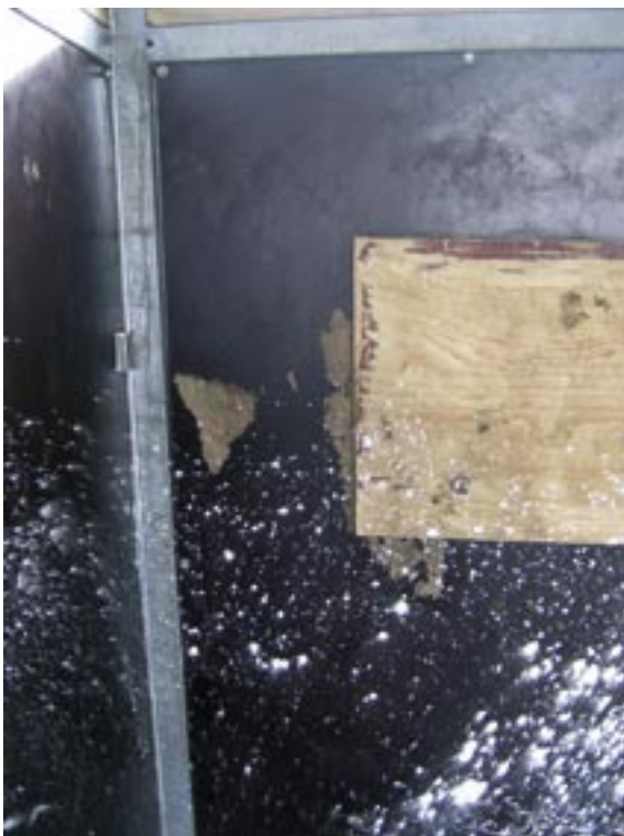
Figur 3 - Skader lavet af kalve på hyttens inderside. Udbedret af landmand ved montering af spånplade.
