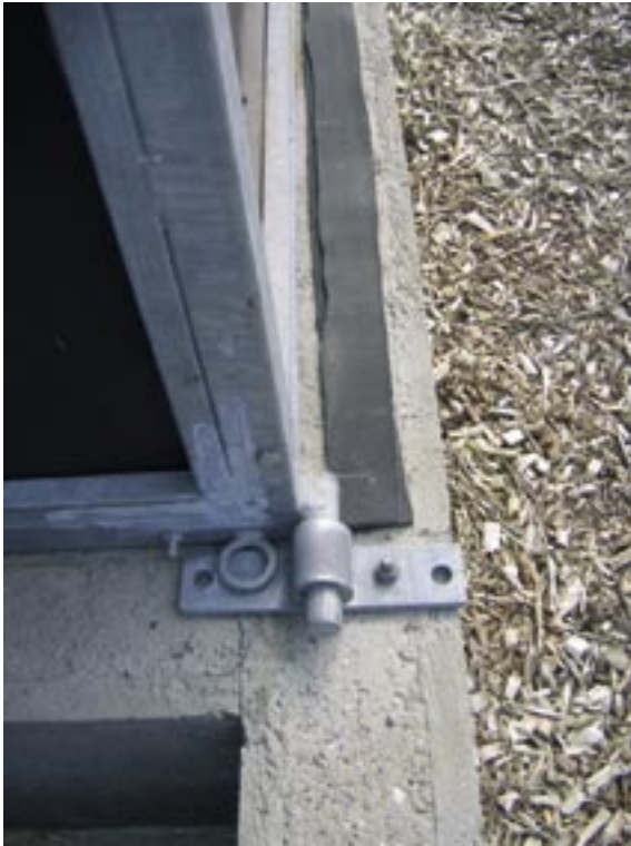
Figur 4 - "Gruppehytte I" forberedt til påsætning af hjulsæt, her monteret i beslag på betonelementer efter landmandens ønske.
