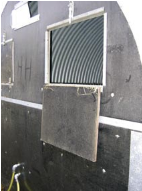
Figur 1 - Foderlåger på baggavl kan ligeledes anvendes som ventilationslemme.
