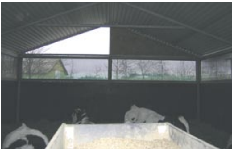
Figur 2 - Den ene halvdel af gavlen er taget ud for at øge ventilationen i hytten.
