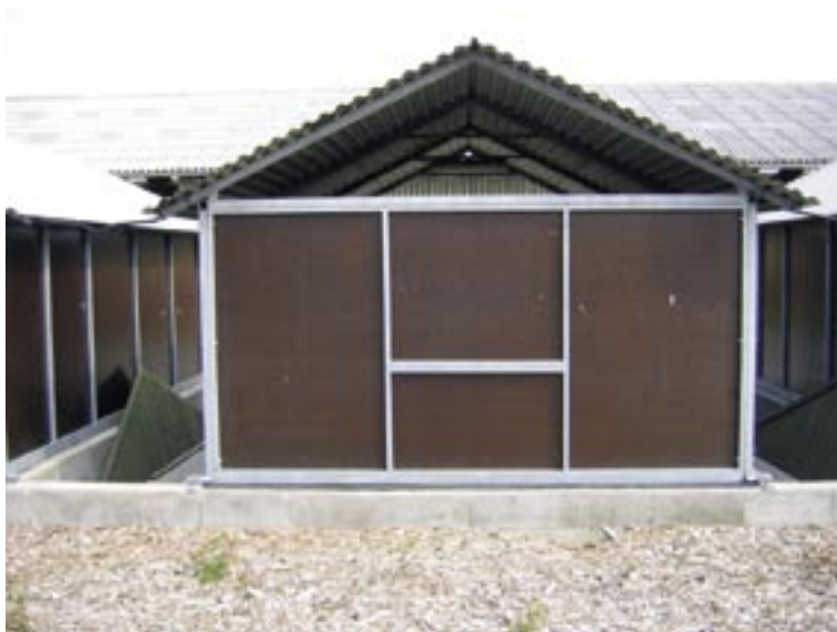
Figur 1 - Åbning i bagvæg på den besøgte "Gruppehytte I", som kan lukkes med vindbrydende bræddetrempele.
