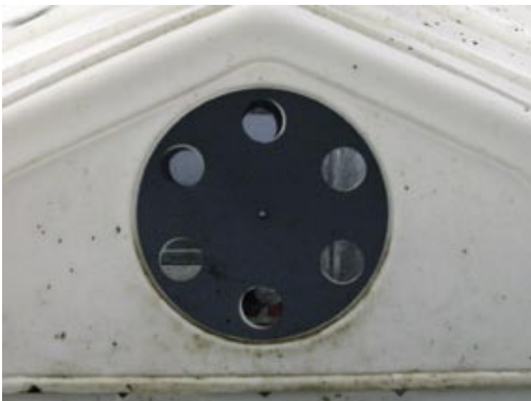
Figur 2 - Regulering af ventilationshuller bagerst i "JFC Fælleshytte" (set indefra).
