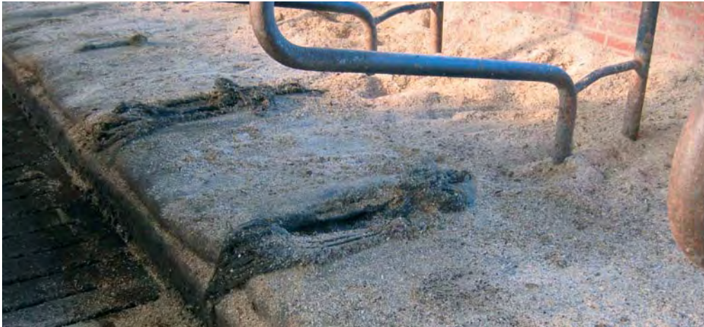
Figur 5.2: Revnede topdug skal skiftes i tide, inden der går hul på f.eks. kanalerne som i dette tilfælde.
