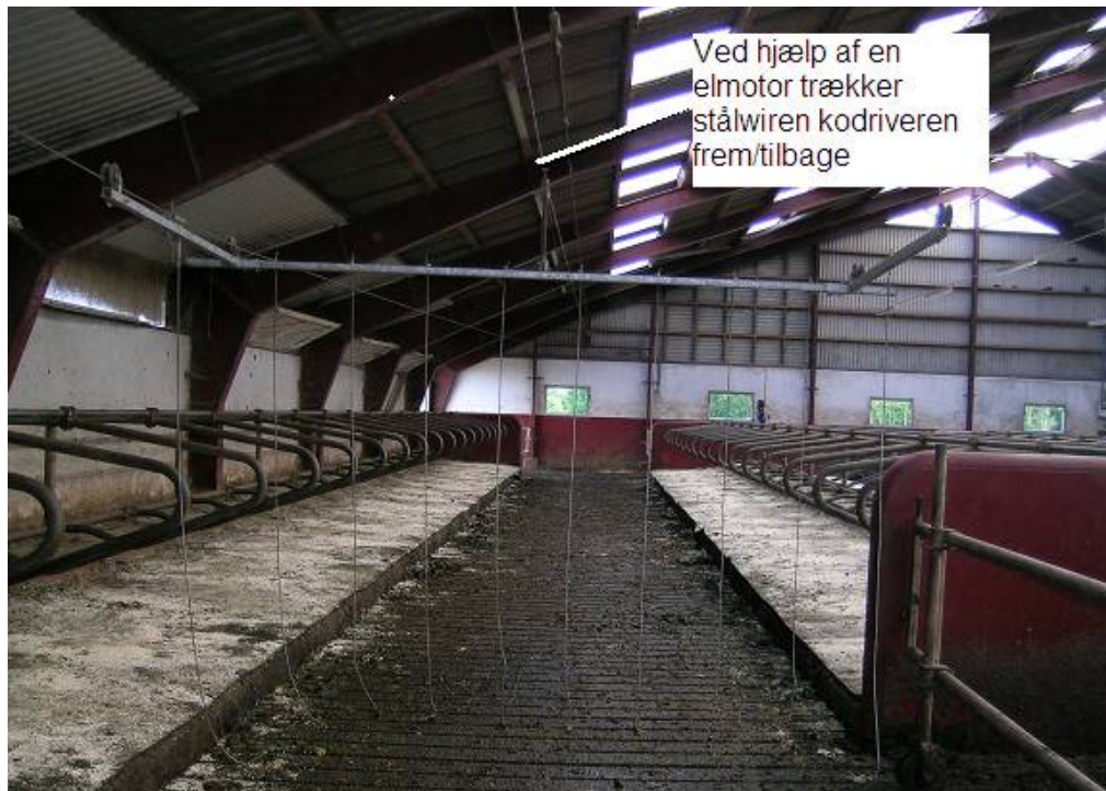
Figur 4.3. Kodriver fra Triomec, enkel og let at installere.
