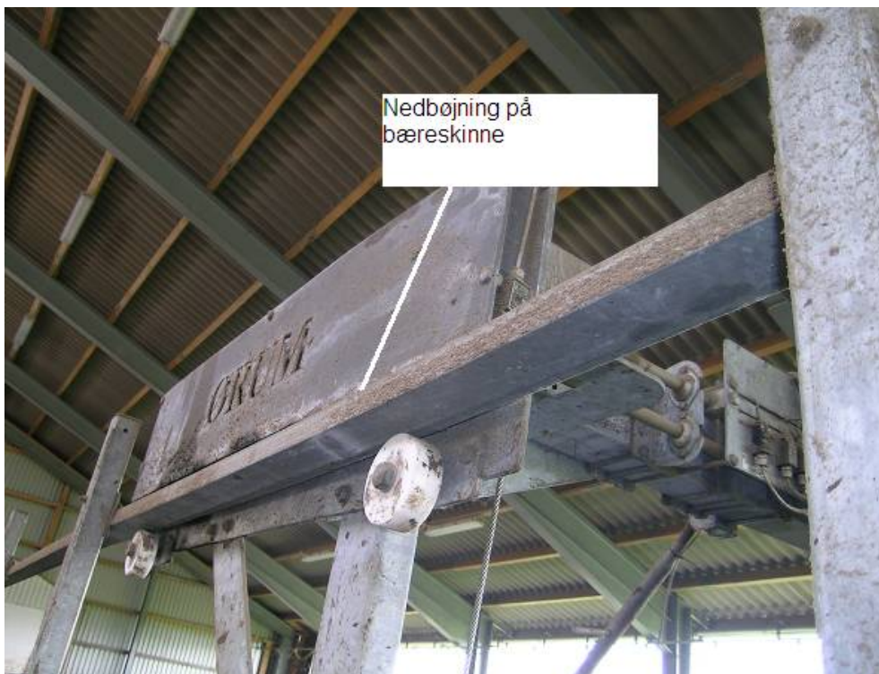
Figur 1.5. Pas på ikke at underdimensionere anlægget, som her, hvor afstanden mellem bærestolperne skal være kortere eller bæreskinnen kraftigere.
