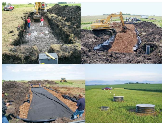
Bioreaktor med træflis. I USA kaldes de woodchip bioreactors. Foto: Laura Christianson og Matthew Helmers, 2011
