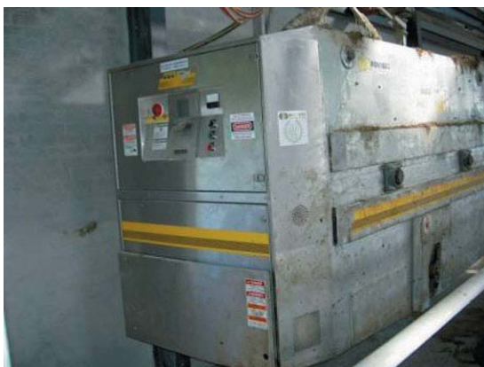
Figur 3.19. Hængebanevognen betjenes via terminalen og udfodrer via en horisontal snegl i højre hjørne af billedet.
