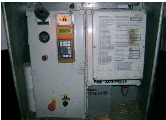
Figur 3.27. Betjening og programmering foregår via et tastatur. Betjeningen kræver interesse og kendskab til elektronik. Den daglige brug er tilfredsstillende men omprogrammeringen er ikke tilstrækkelig brugervenlig.
