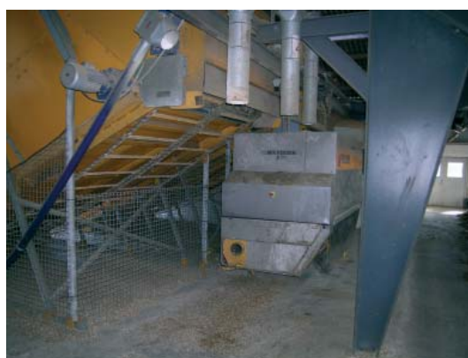
Figur 3.32. Vognen fyldes vha. fordelerbord og flexsnegle. Foderspildet er meget begrænset.
