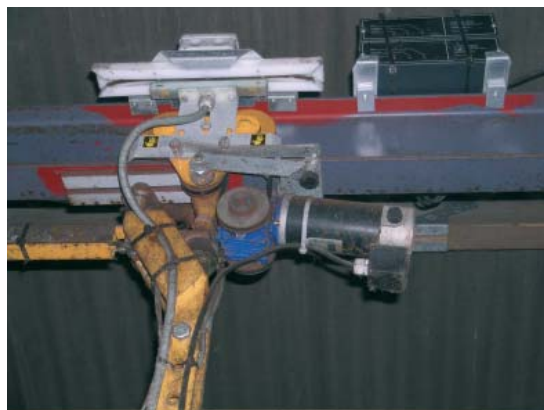
Figur 3.28. Vognen er ophængt i en skinne og trækkes af to el-motorer. Disse drives af batterier som er monteret på hængebanen. Batterierne oplades når hængebanen ikke udfodrer.
