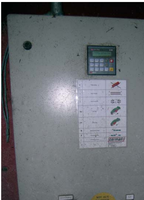
Figur 3.9. Betjening og programmering foregår via et display eller pc. Betjeningen kræver begrænset interesse og kendskab til elektronik og er simpel og velfungerende.
