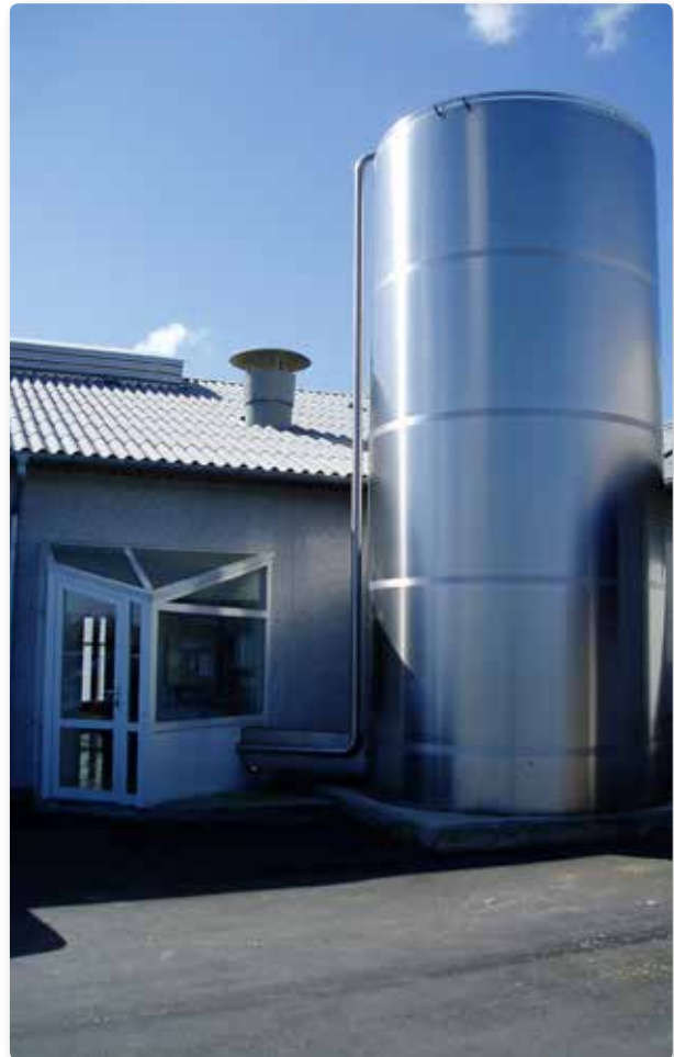
Aftræksskorsten med ventilation ført op gennem loftet.
