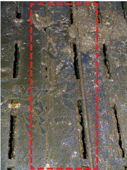
Figur 20. Forskudt spalteåbning mellem gummi- og betonspalte. (Se stiptet markering).
