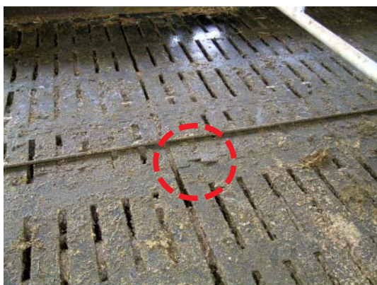
Figur 32. Samling af gummigulv, der vipper op. (Se stiplede markering).
