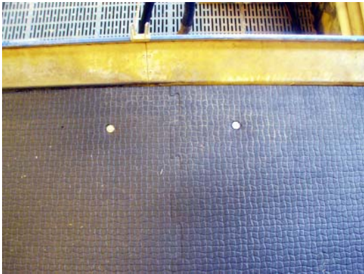
Figur 15. Montering af fast gummigulv med rustfrie skruer.
