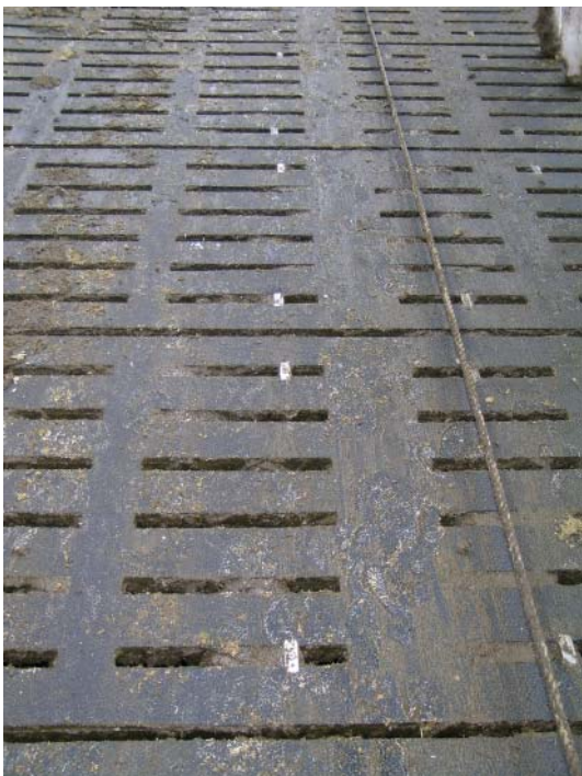
Figur 17. Montering af spaltegummigulvet med metalspænder.
