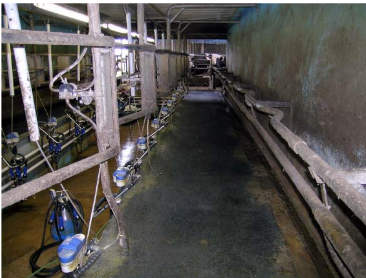
Figur 14. Fast gulv med gummibelægning.
