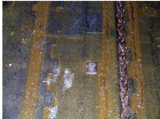
Figur 16. Montering af fast gummigulv med gummisøm.
