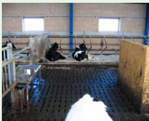
Figur 1.11. God plads. Tværgangen er 30 cm bredere end minimumsbred- den for tværgange med vandkar.
