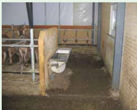
Figur 2.19. (venstre) Tværgang med vandkar som er mindst 20 cm smal- lere end anbefalet.
