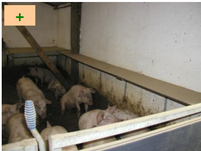
Pkt. 5. Prelleplade på væg
