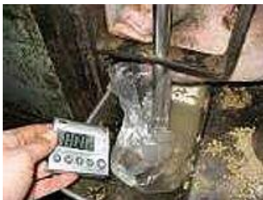
Kontrol af vandydelse i foder-automat
