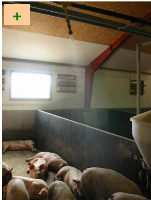
Korrekt placeret overbrusning med fladdyser
