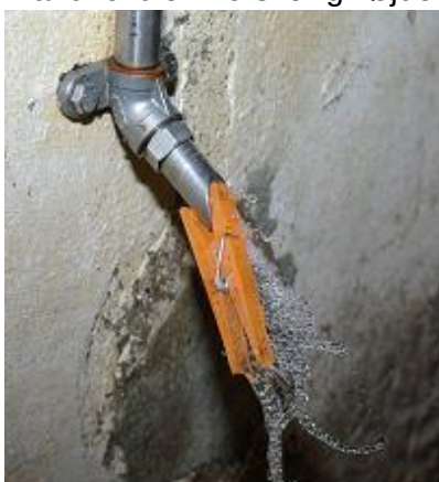
En simpel måde til gennemskylning af rør
