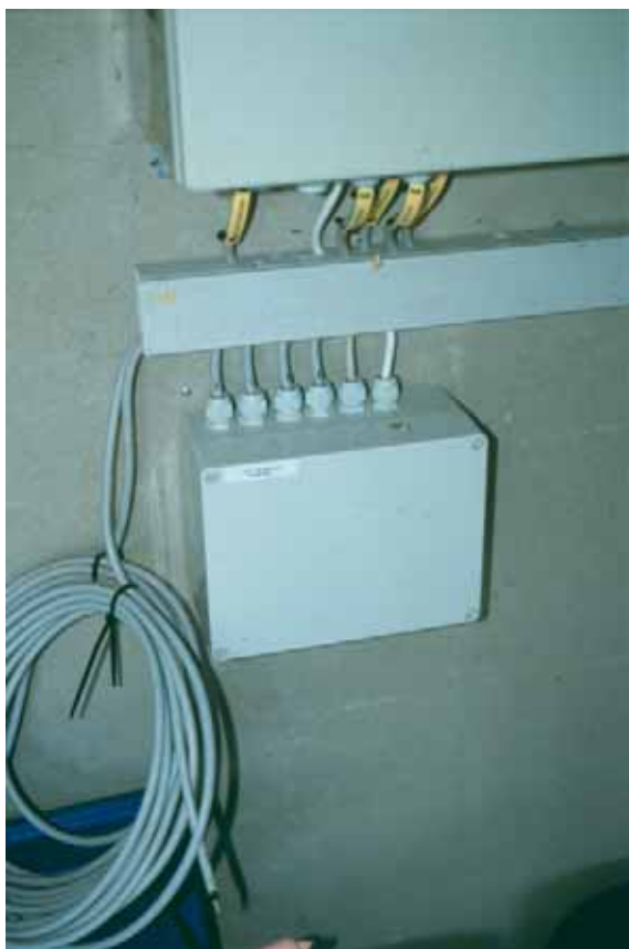
Figur 30. Procesenheden var placeret i en beskyttelsesboks i et teknikrum.
