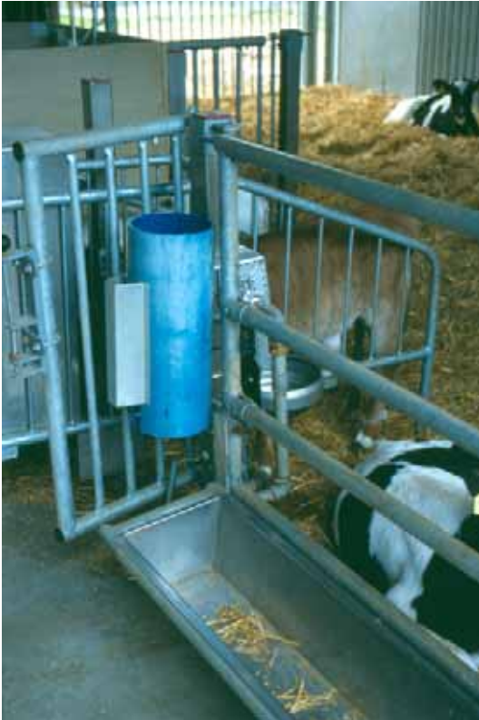
Figur 31. Her ses vanduret på en vandkop med afdækning (blå rør) og uden afdækning. Afdækningen er nødvendig, for at kalvene ikke skal ødelægge uret.
