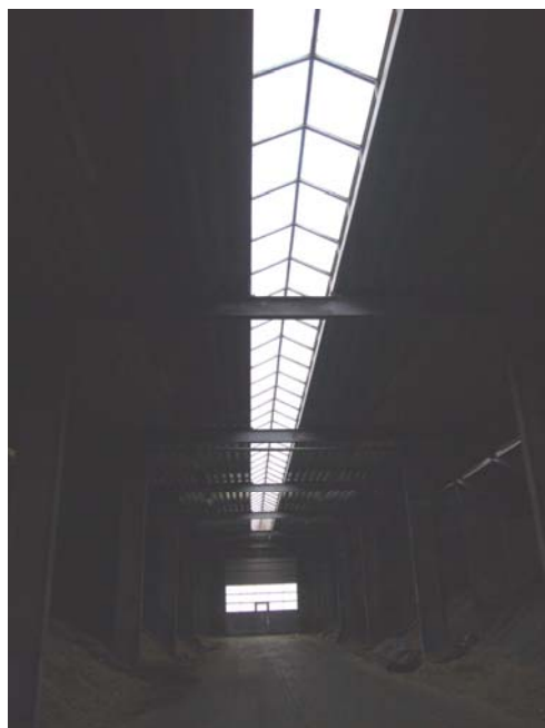
Figur 4.12. Indendørs plansiloer. Kip i loftet giver godt lysindfald.
