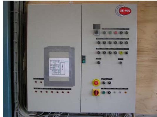
Figur 4.6. Der kræves en fornuftig styretavle til de mange snegle og udtag.
