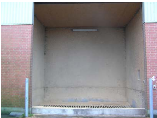
Figur 4.7. Lukket korngrav til hele lastbiltræk – vigtigst af alt er en stor høj port.
