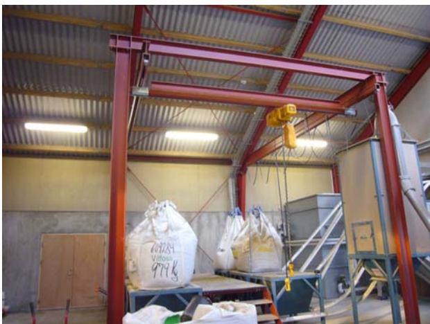
Figur 4.19. Et godt system der nemt kan klare storsække.
