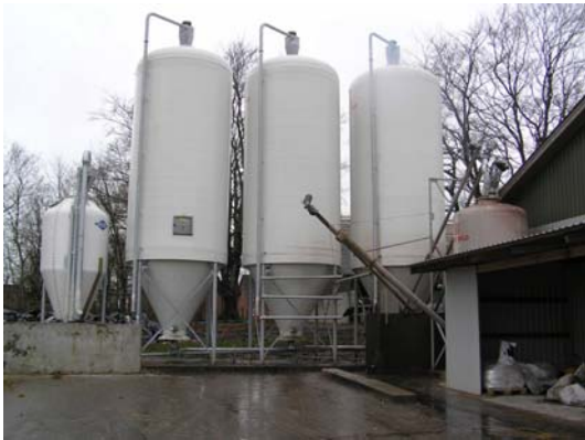
Figur 4.15. Der er 3 udendørssiloer til tilskudsfoder og en udendørs mineralsilo. Dertil kommer udtagningsiloen, som i dette tilfælde er placeret på vejeceller på jorden, hvor foderet via en snegl fyldes i fuldfodervognen.
