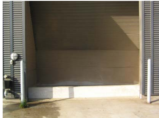
Figur 4.2. Lukket korngrav med 5,5 m port og den må ikke være lavere ifølge landmanden.
